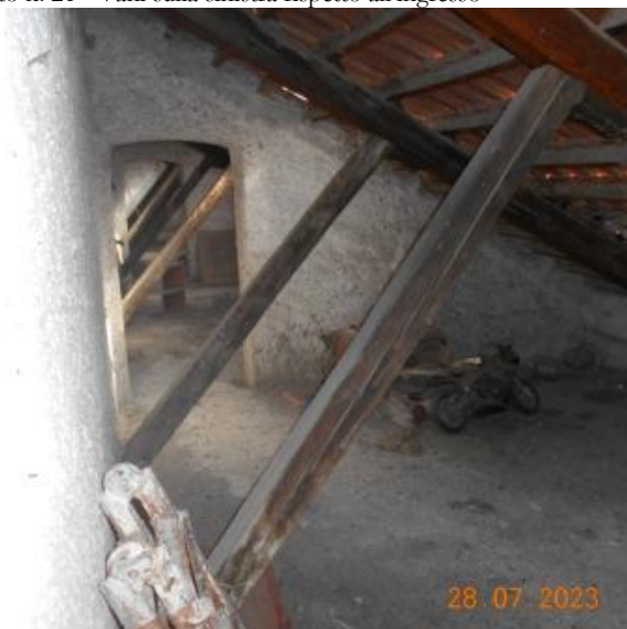
Foto n. 21 - Vani sulla sinistra rispetto all'ingresso
