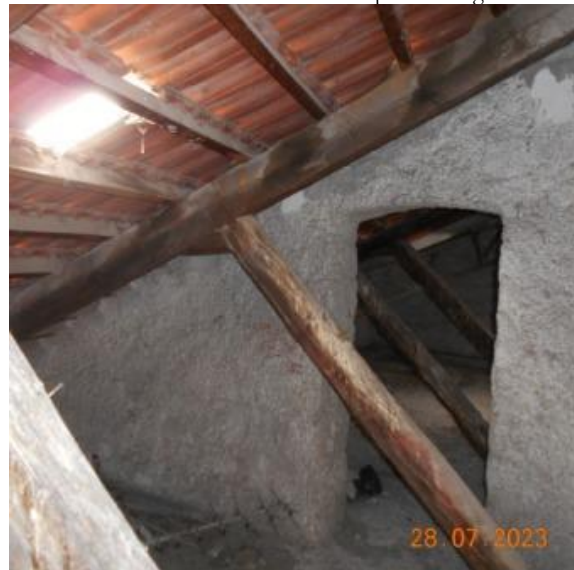
Foto n. 20 - Due ambienti a sinistra rispetto all'ingresso
