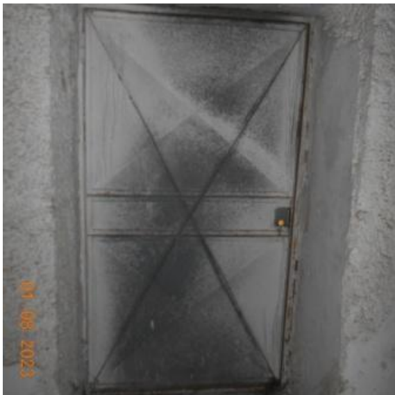
Foto n. 54 - Portoncino di accesso al sottotetto dalla scala B
