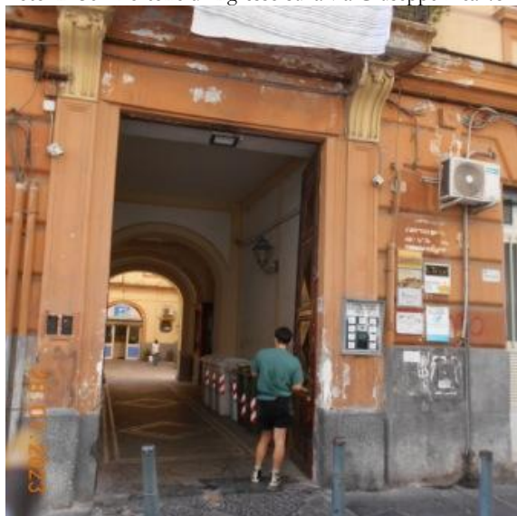
Foto n. 36 - Portone di ingresso sulla via Giuseppe Pica 48
