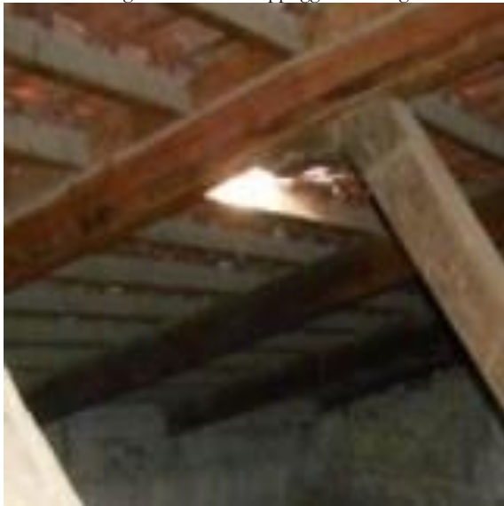
Foto n. 5 - Maglia reticolare di appoggio delle tegole
