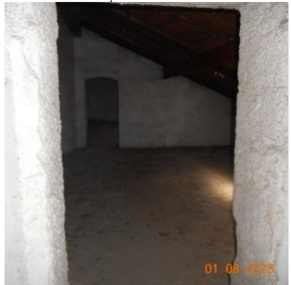
Foto n. 53 - Ambienti più interni sul fronte del cortile interno
