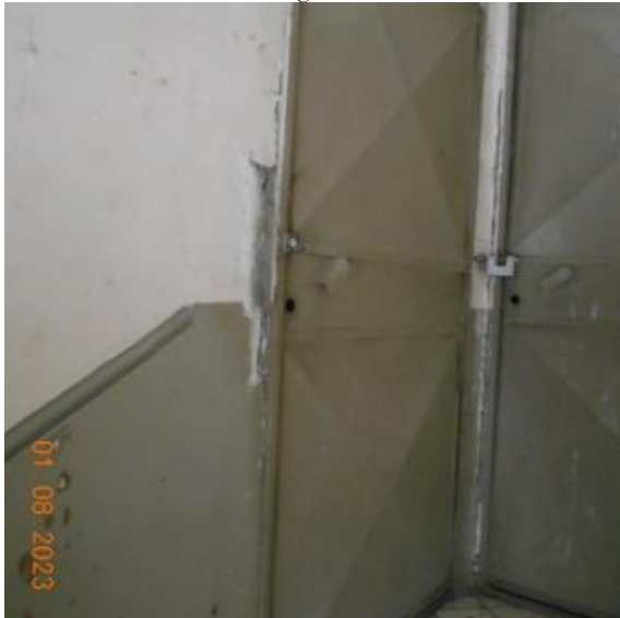
Foto n. 46 - Portoncino d'ingresso al sottotetto
