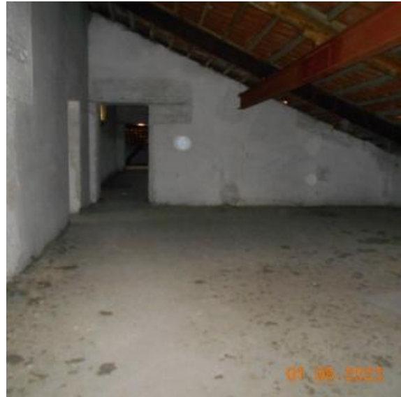
Foto n. 51 - Ambienti comunicanti sul lato ad est
