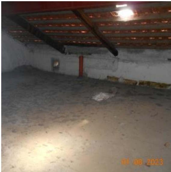
Foto n. 52 - Altri ambienti sul lato ad est
