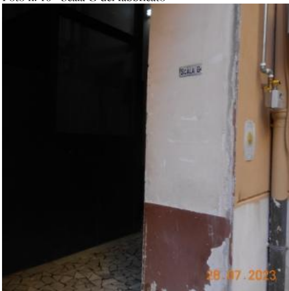
Foto n. 16 - Scala G del fabbricato
