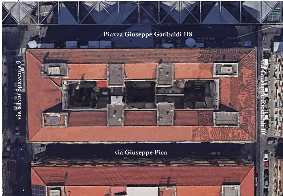
Foto n. 25 - Vista dall'alto delle mansarde in Napoli con accesso dalla Piazza Giuseppe Garibaldi 118, da via Giuseppe Ricciardi 10 e da via Silvio Spaventa 9
