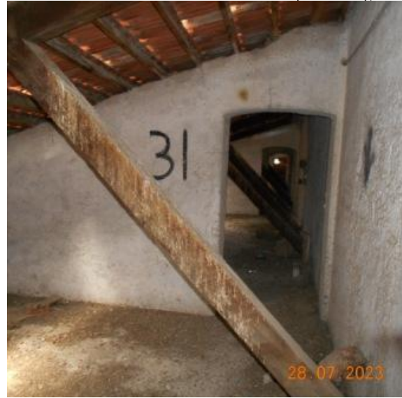
Foto n. 41 - Tompagnatura di chiusura in direzione ovest
