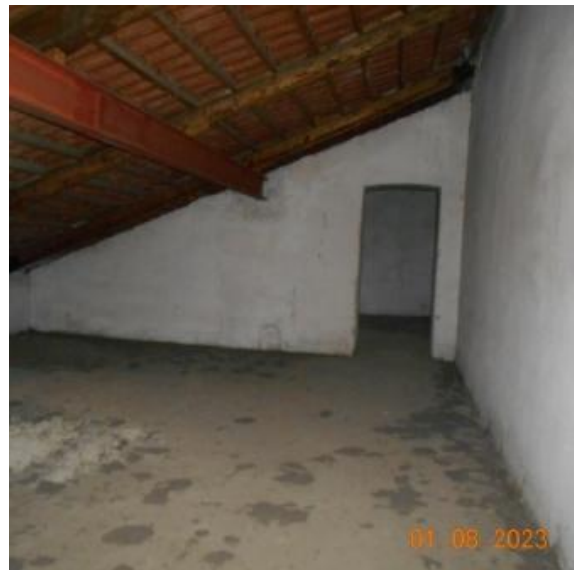
Foto n. 55 - Ambienti comunicanti sul fronte a nord
