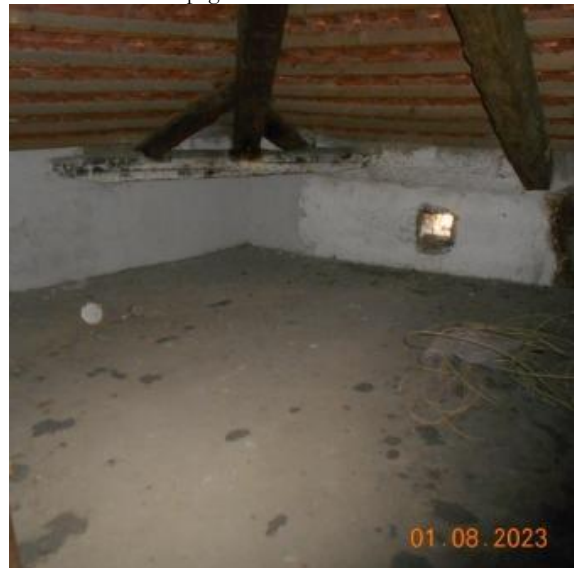
Foto n. 49 - Tompagnatura del lato a sud
