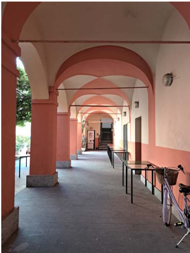
Figura 5- portico d'ingresso da via Faà di Bruno
