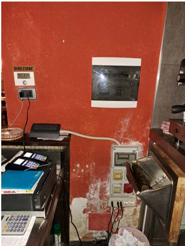
Figura 30- area ingresso bancone
