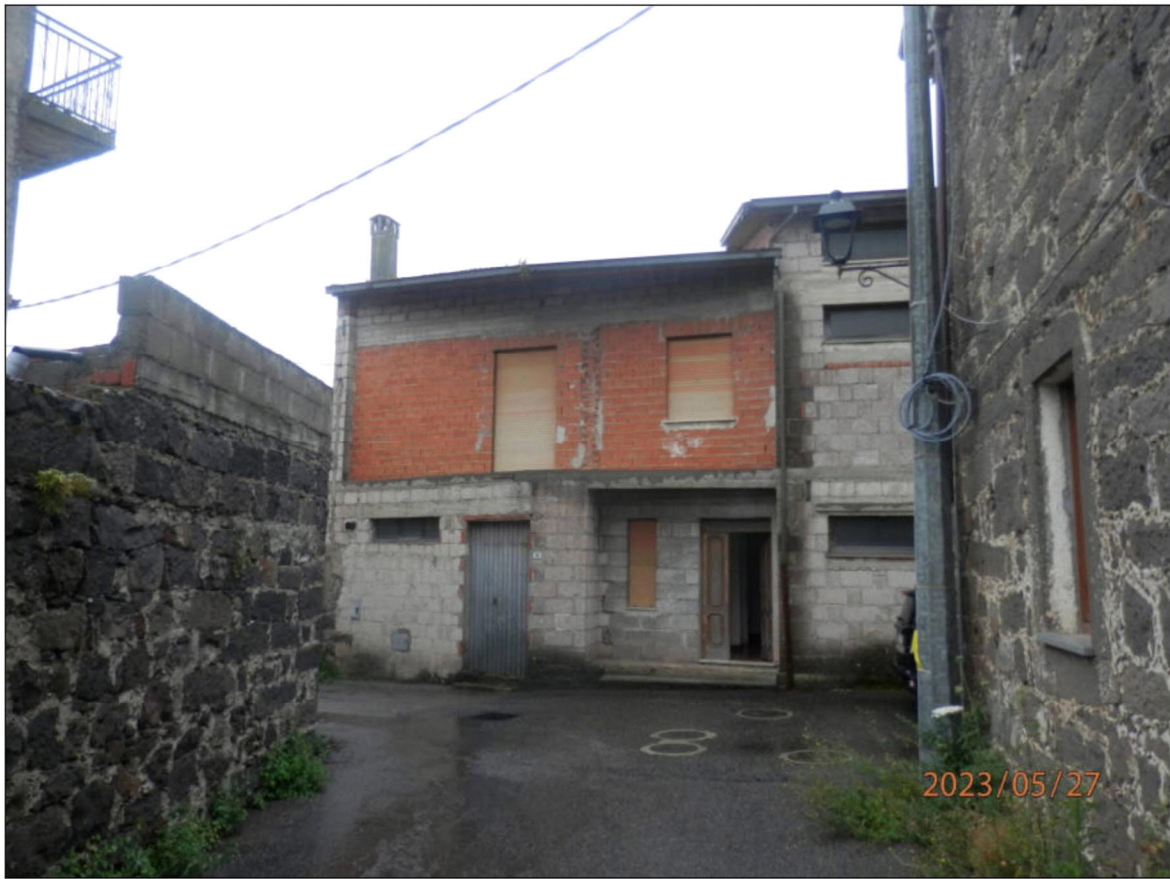
Fotografia N. 1 - Vista dalla Via Brigata Sassari
