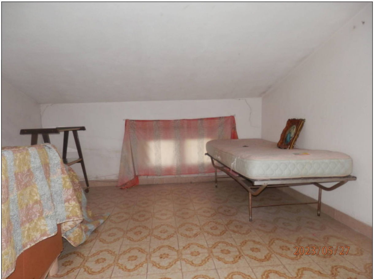
Fotografia N. 26 - Vista Sottotetto 1, 12,45 mq - Piano Secondo
