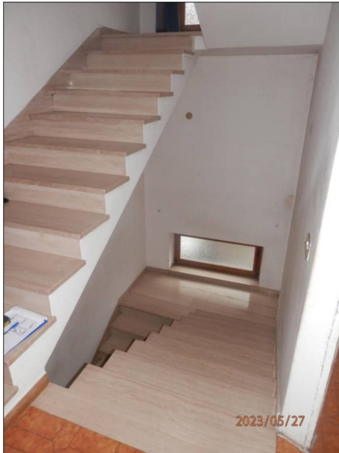
Fotografia N. 1 5 " Vista Vano scala - Piano Terra e Primo
