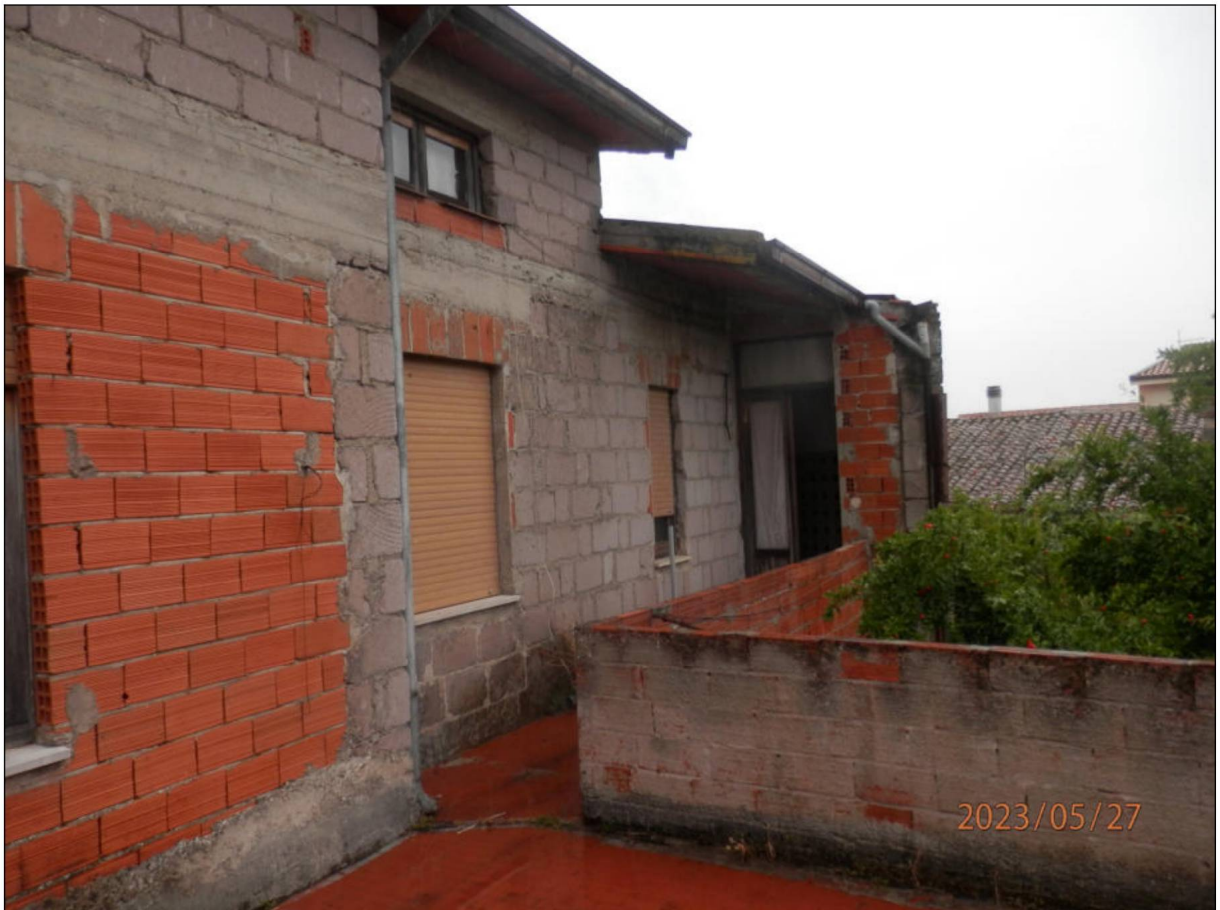
Fotografia N. 24 - Vista Terrazza 26,90 mq - Piano Primo
