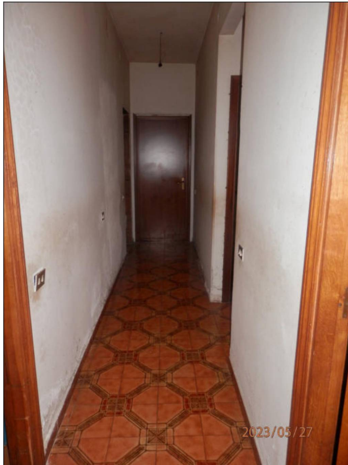
Fotografia N. 7 - Disimpegno 6,75 mq - Piano Terra
