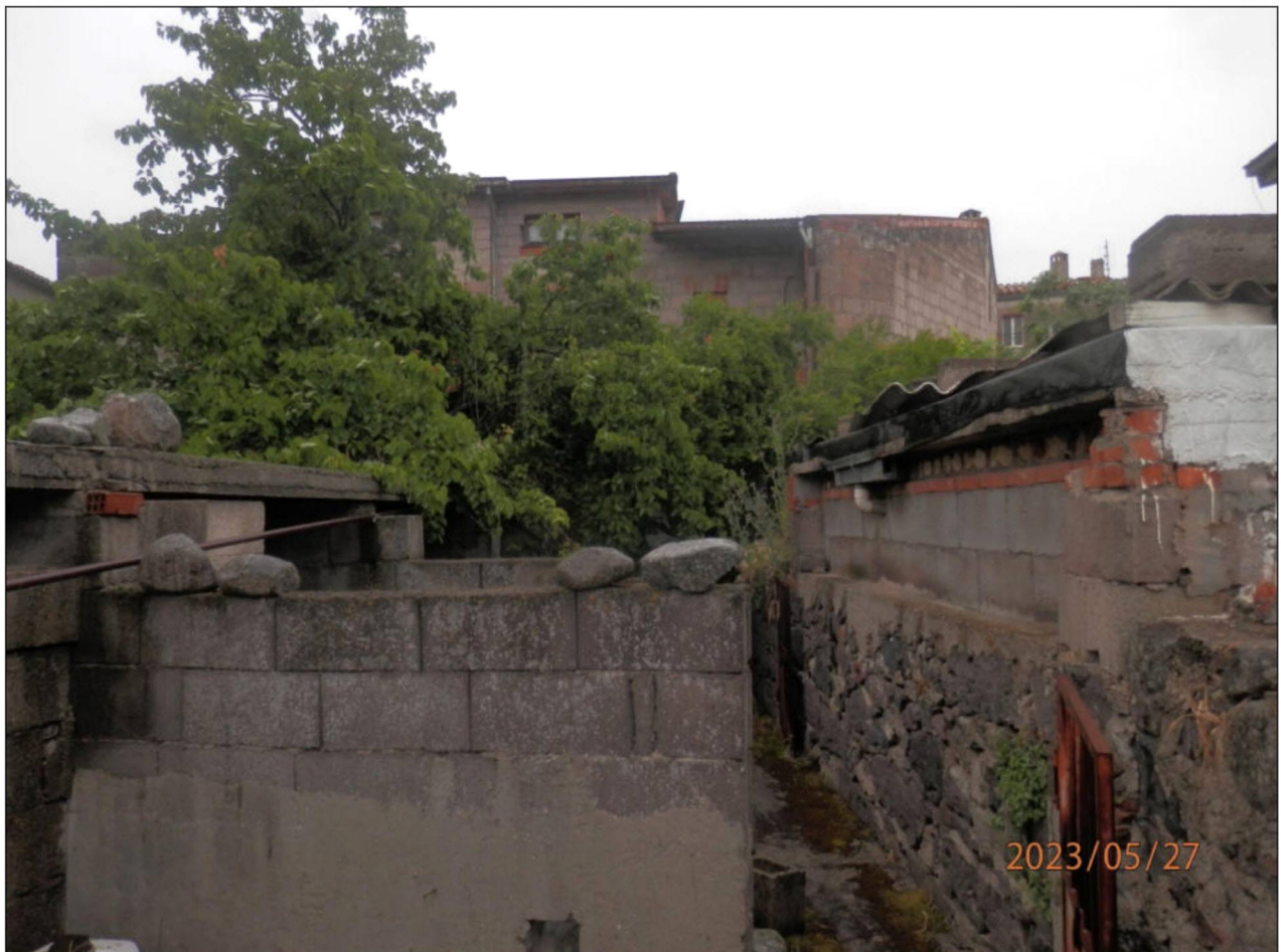
Fotografia N. 4 " Vista dal cortile Prospetto retro
