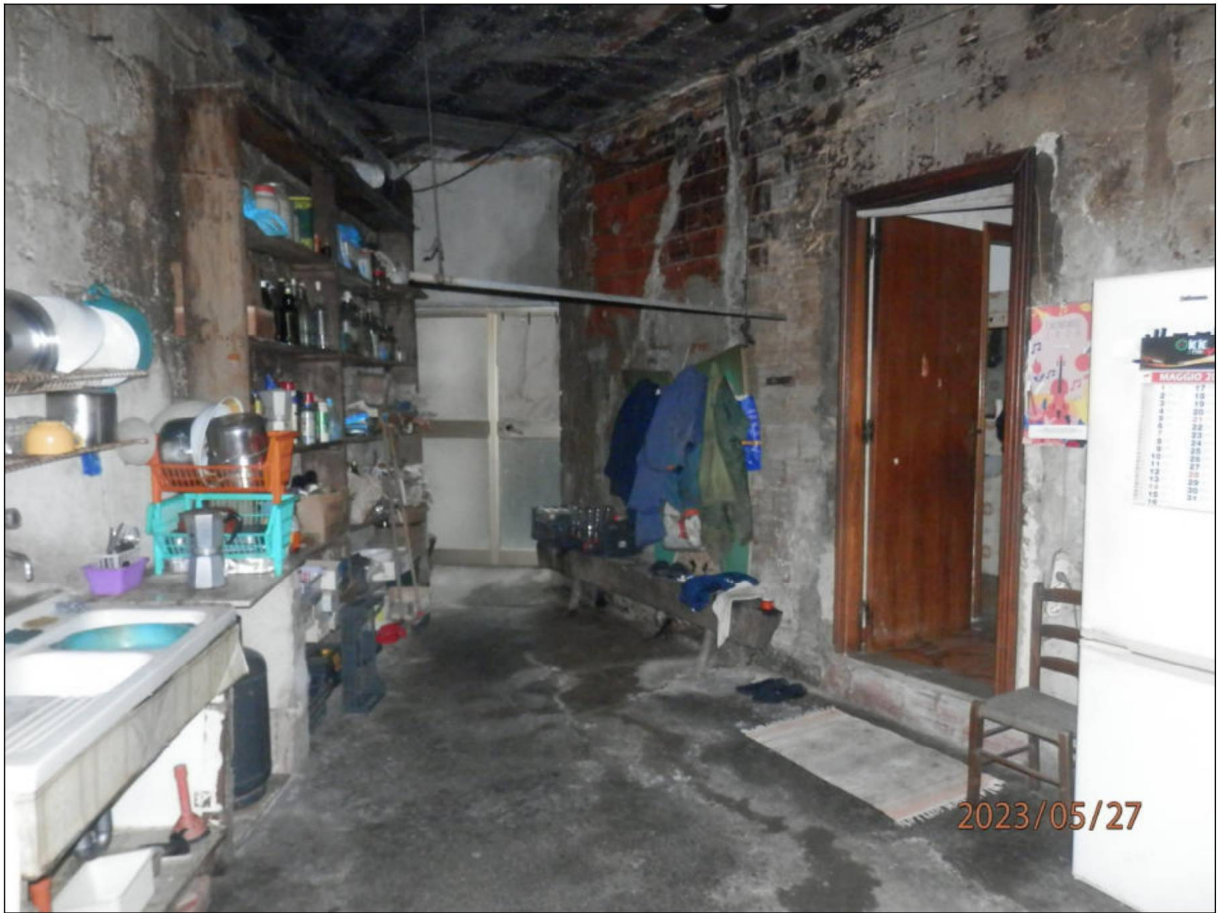
Fotografia N. 9 - Locale di Sgombero 23,90 mq - Piano Terra
