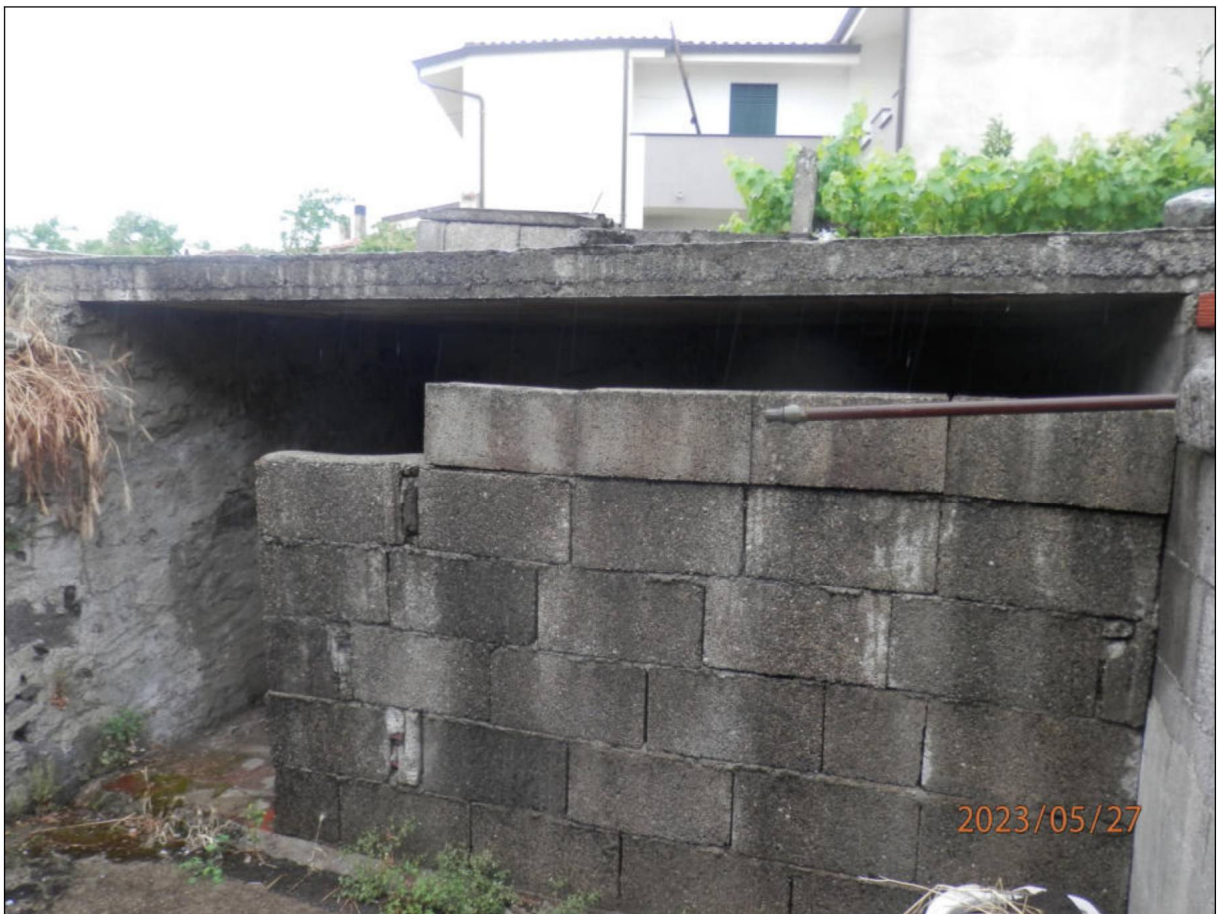
Fotografia N. 14 - Vista Tettoia 3 8,35 mq - Piano Terra
