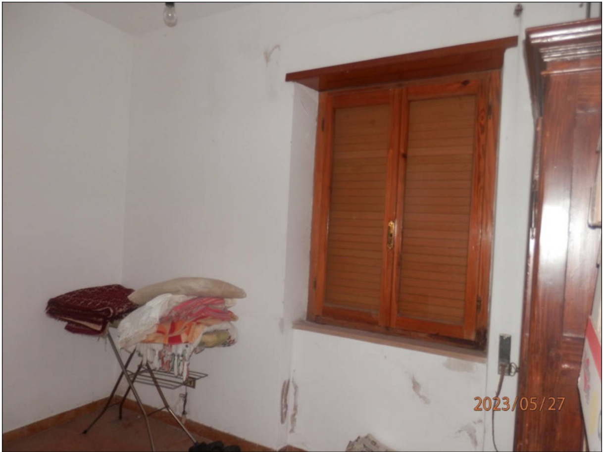
Fotografia N. 21 - Vista Ripostiglio 7,40 mq - Piano Primo
