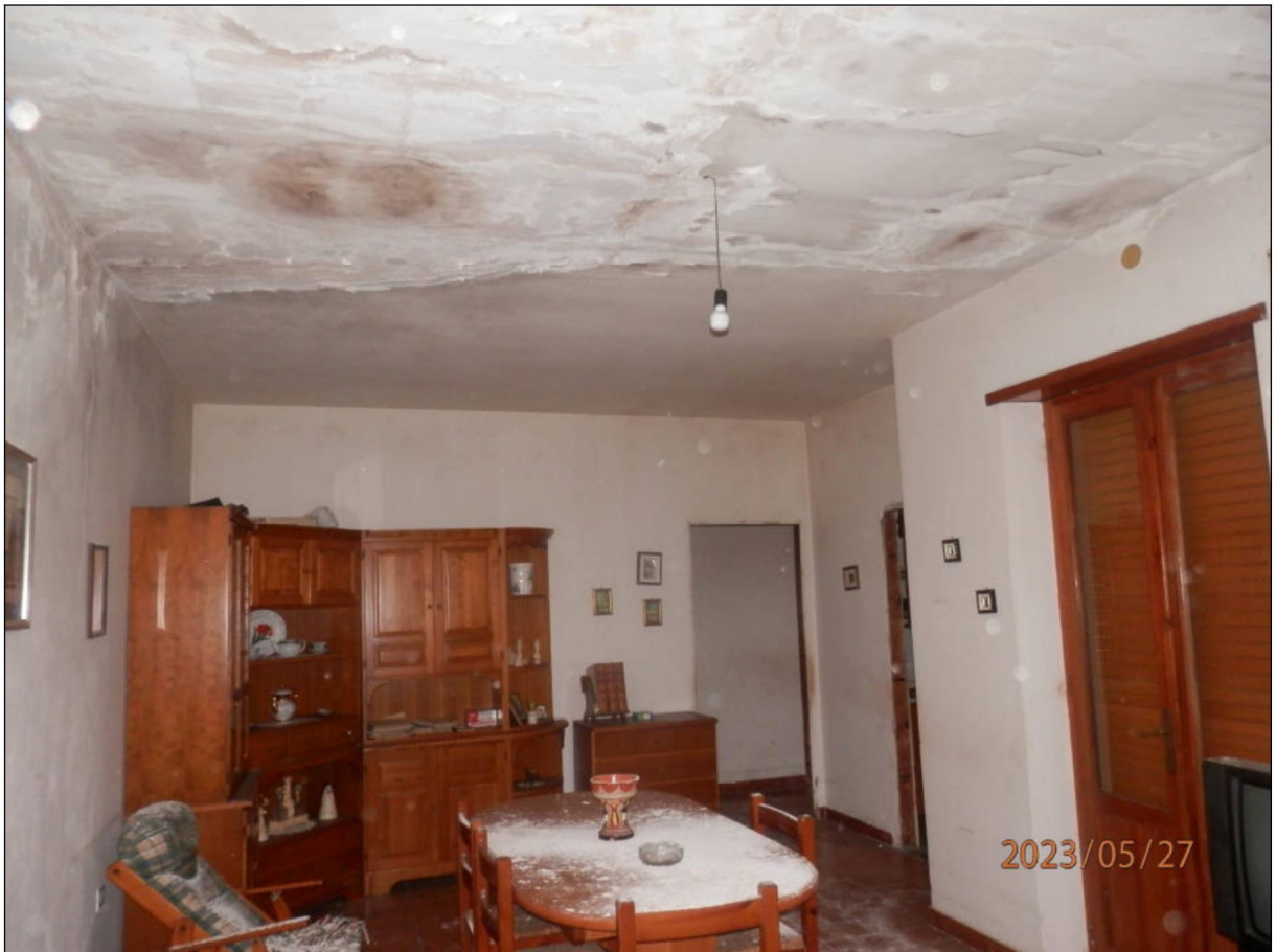
Fotografia N. 12 - Vista Soggiorno Pranzo 27,55 mq - Piano Terra
