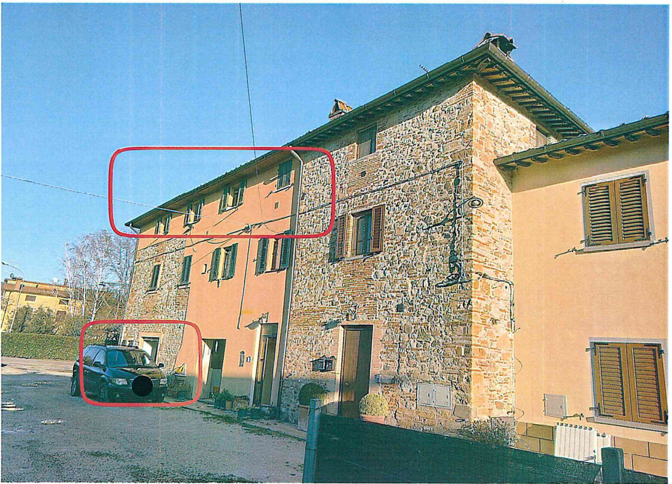
FRONTE PRINCIPALE VERSO AREA SCOPERTA
