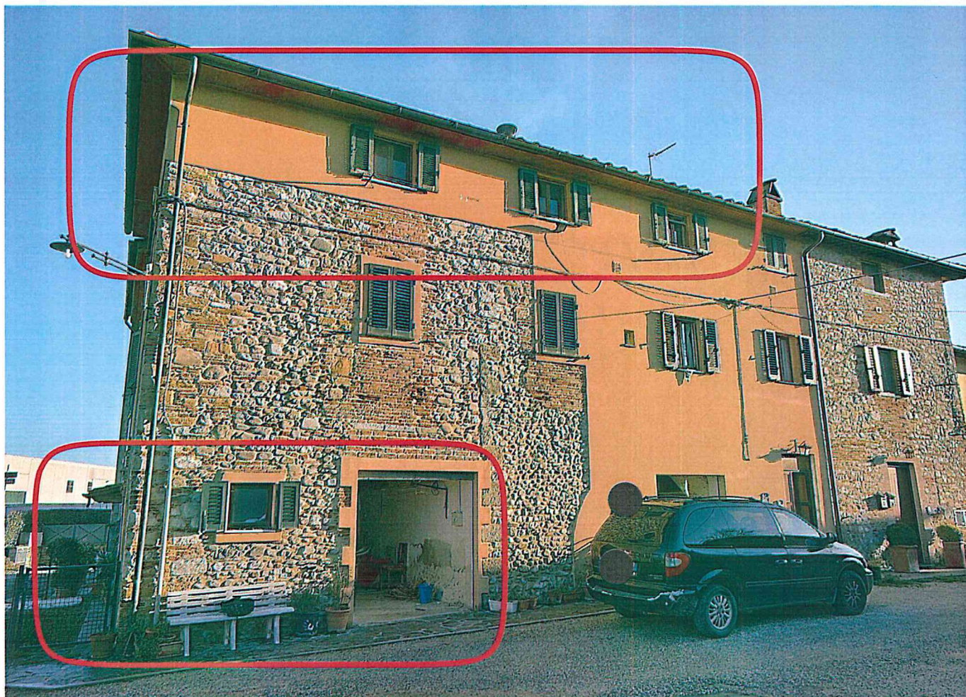
FRONTE PRINCIPALE VERSO AREA SCOPERTA
