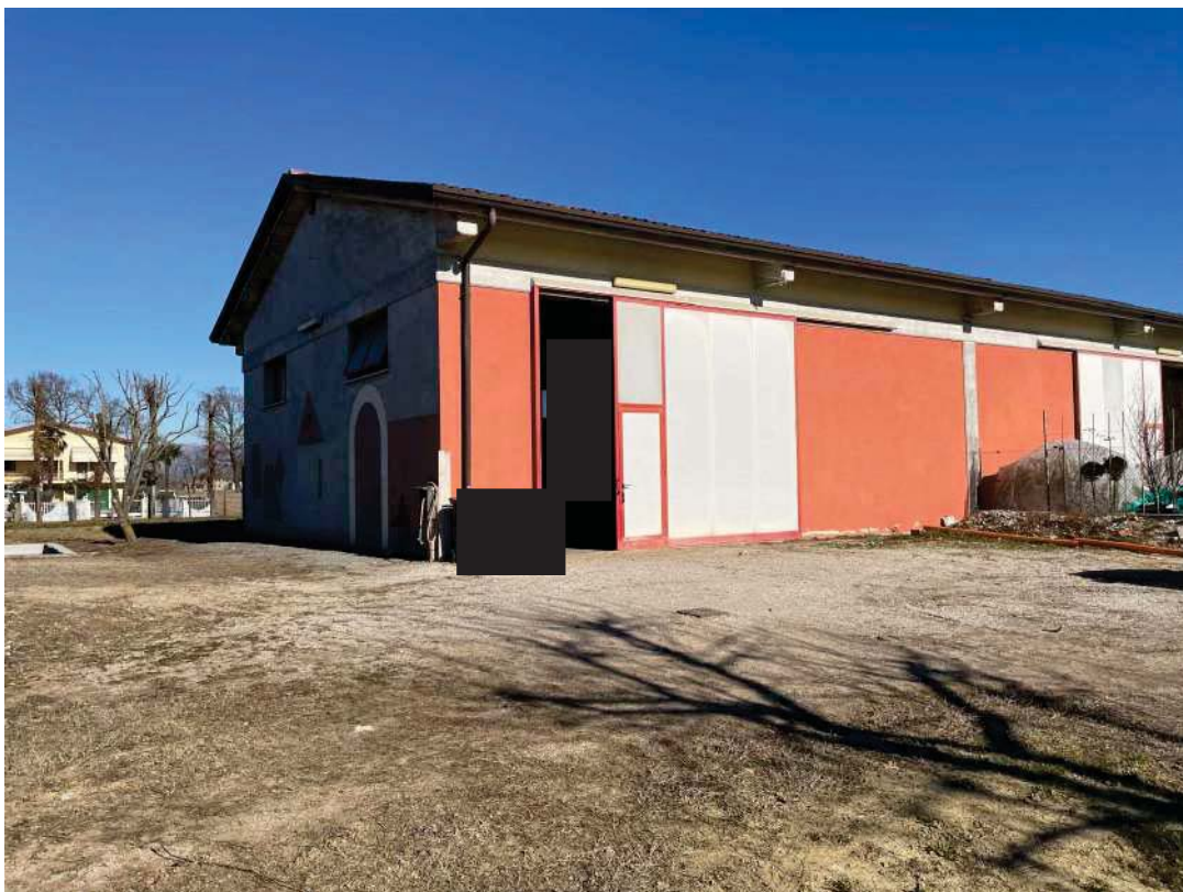
Particolare esterno magazzino deposito attrezzi
