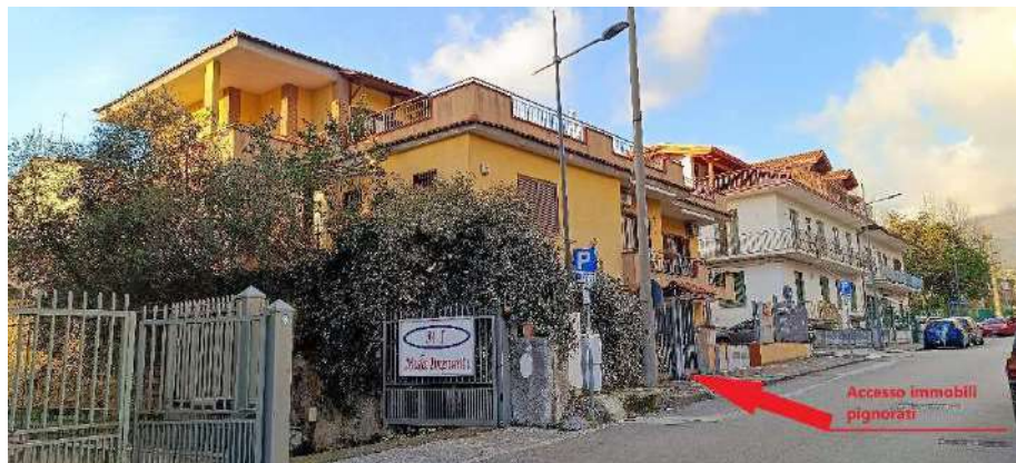
1. Vista fabbricato da Via Ferrovia
