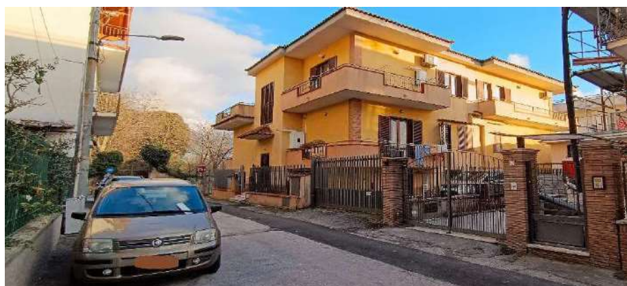
3. Vista fabbricato da Via Gramsci
