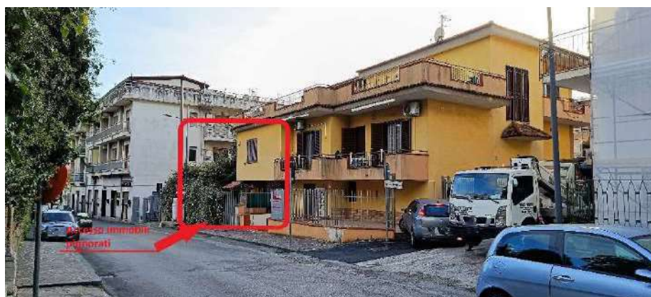
2. Vista fabbricato da Via Ferrovia
