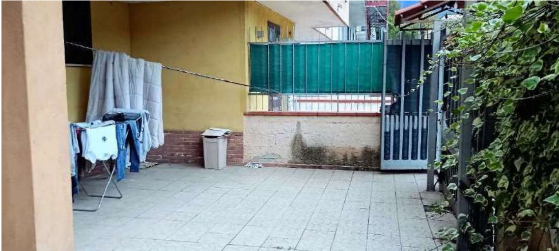
4. Corte esterna piano terra Ingresso da Via Ferrovia
