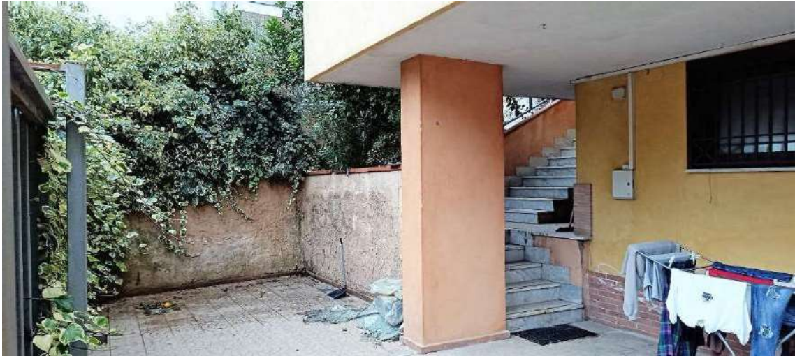
6. Corte esterna piano terra Lato Via Ferrovia
