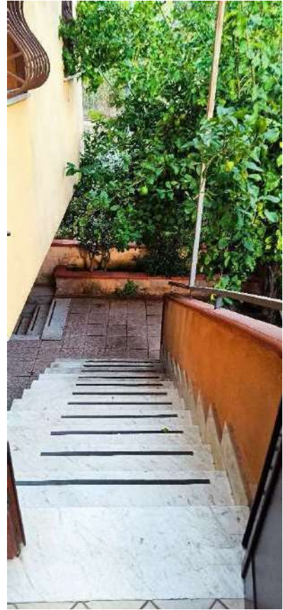
8. Scala di accesso al piano 1°
