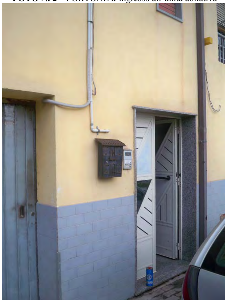
FOTO N. 2 – PORTONE d'ingresso all'unità abitativa
