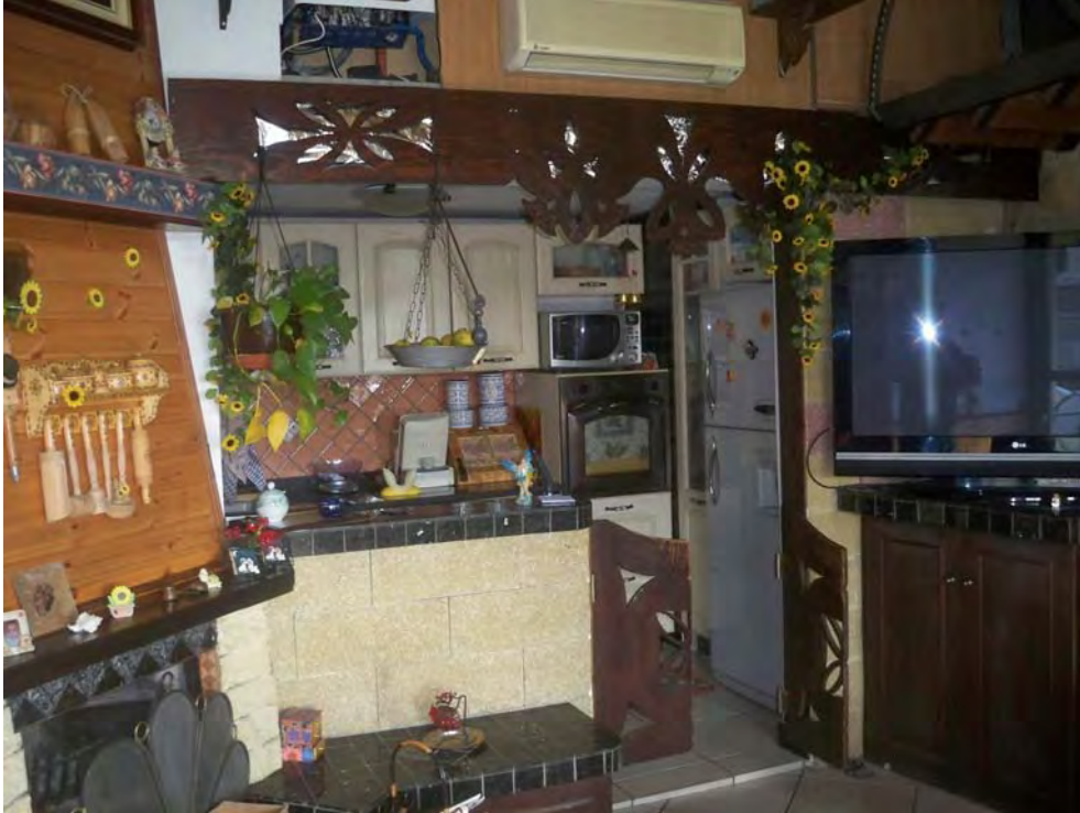
FOTO N. 17 – Cucina-pranzo realizzata abusivamente su terrazza di progetto
