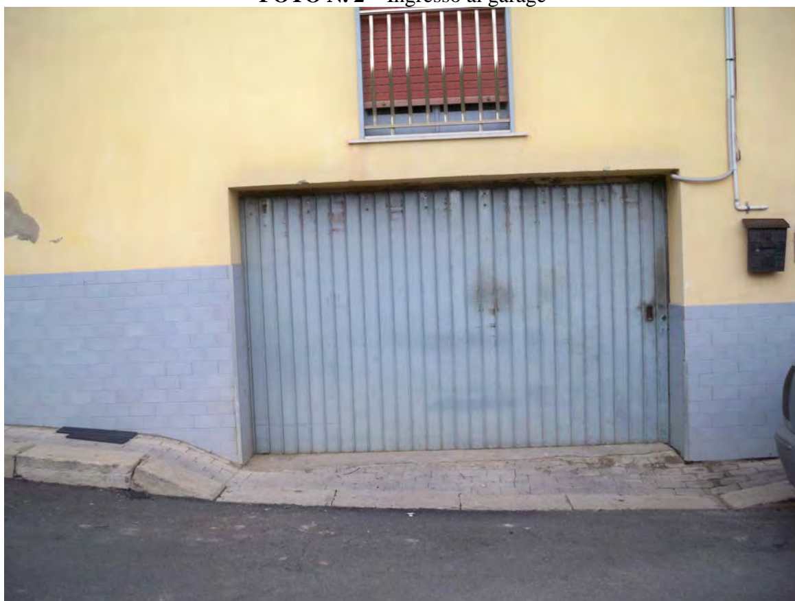
FOTO N. 2 – Ingresso al garage
