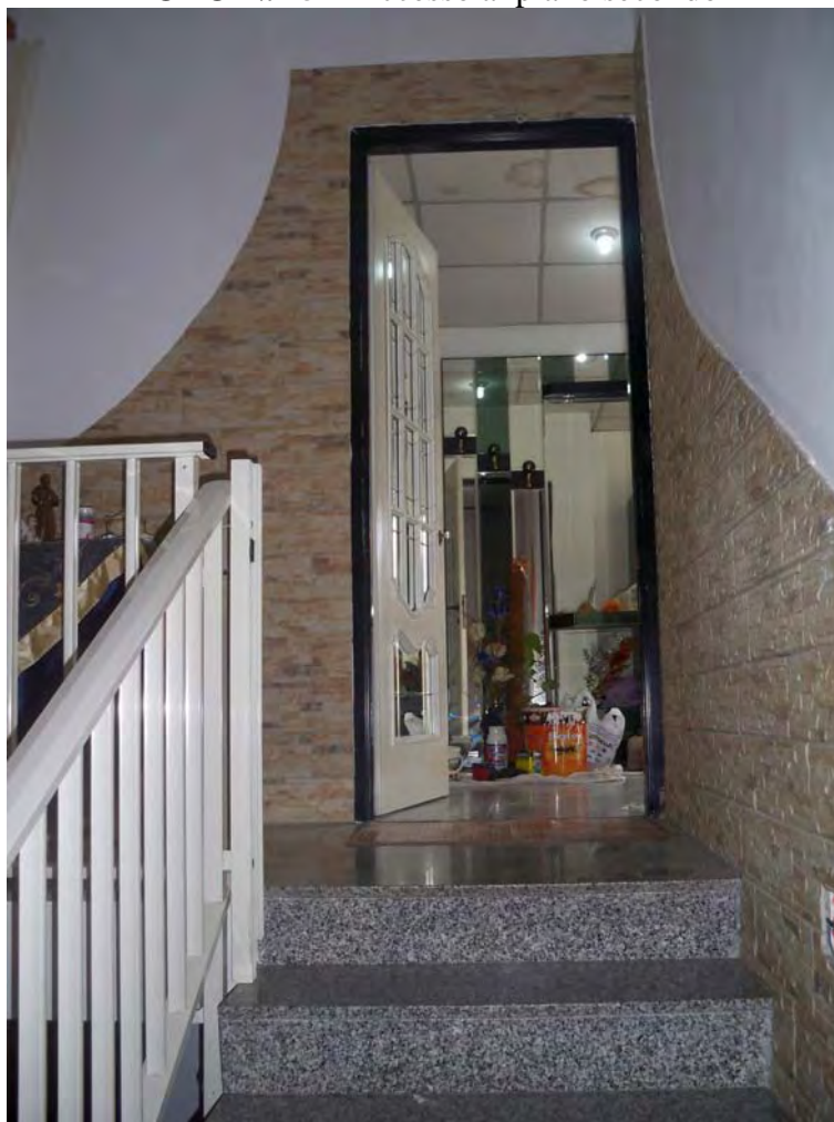
FOTO N. 15 – Accesso al piano secondo
