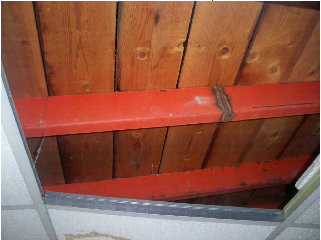
FOTO N. 30 – Particolare tetto di copertura
