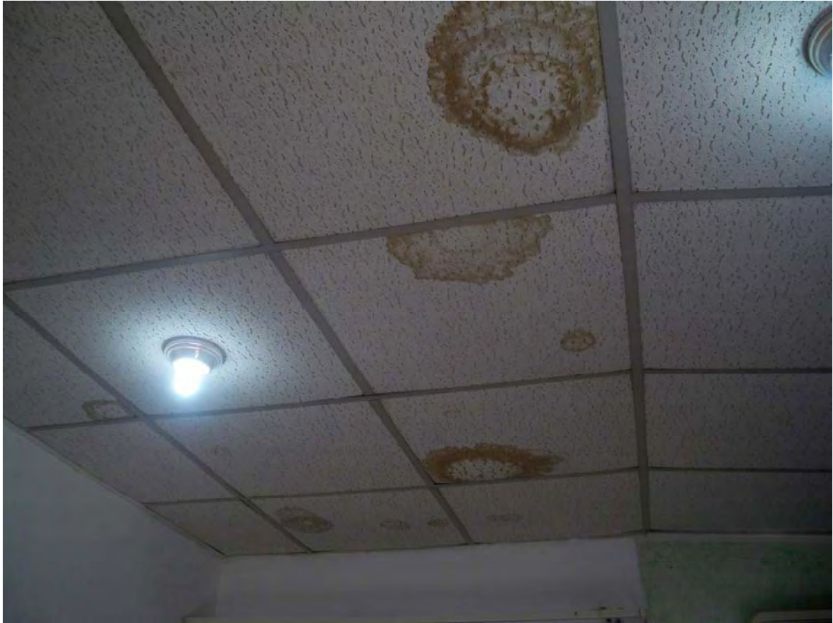
FOTO N. 29 – Particolare controsoffitto esistente
