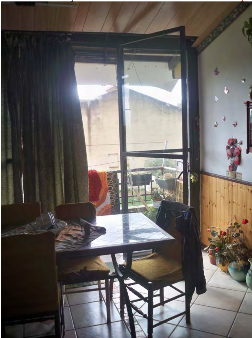
FOTO N. 18 – Cucina-pranzo realizzata abusivamente su terrazza di progetto
