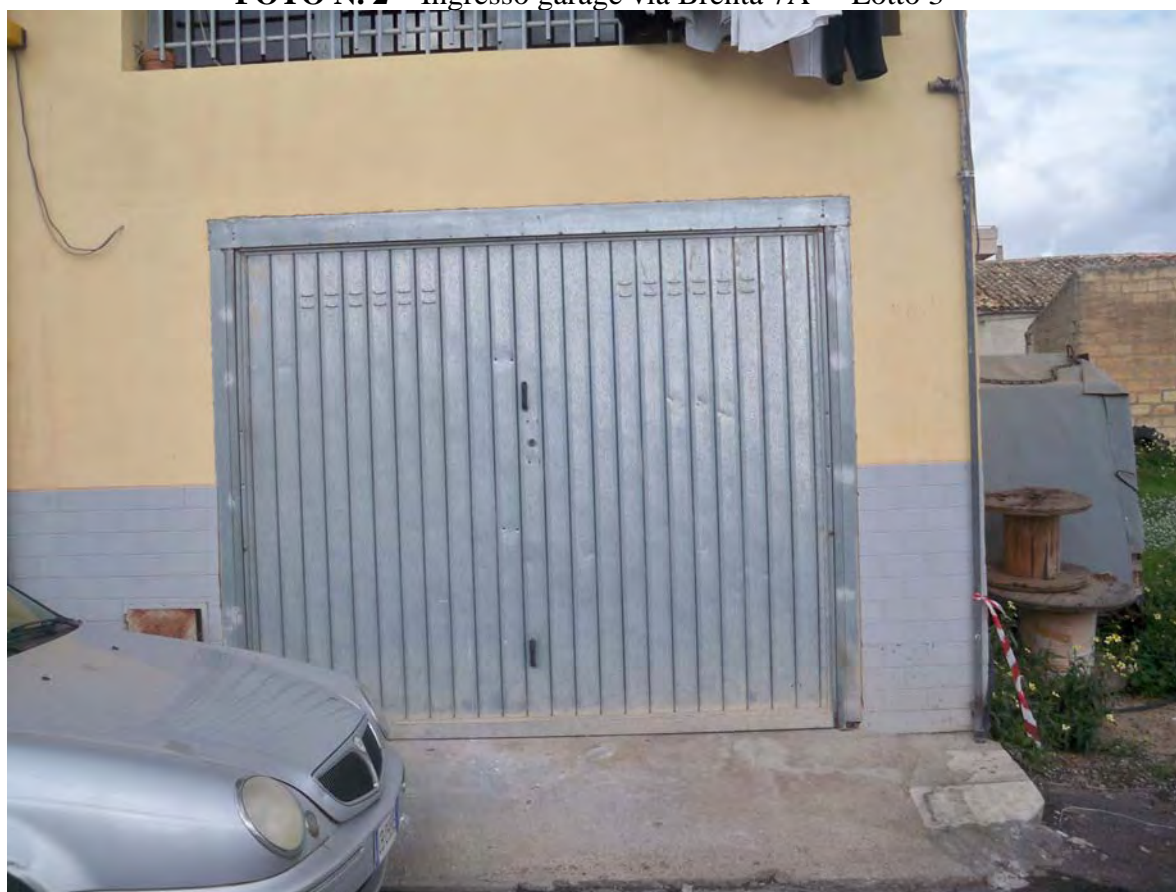
FOTO N. 2 – Ingresso garage via Brenta 7A - “Lotto 3”
