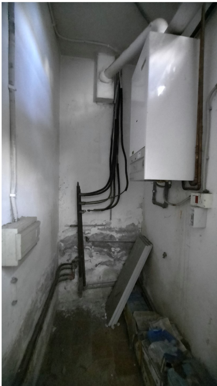
Foto 15 - vano centrale termica
