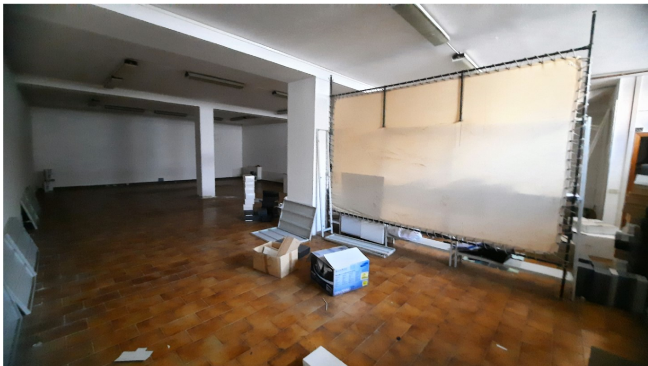
Foto 12 - magazzino al piano sottostrada
