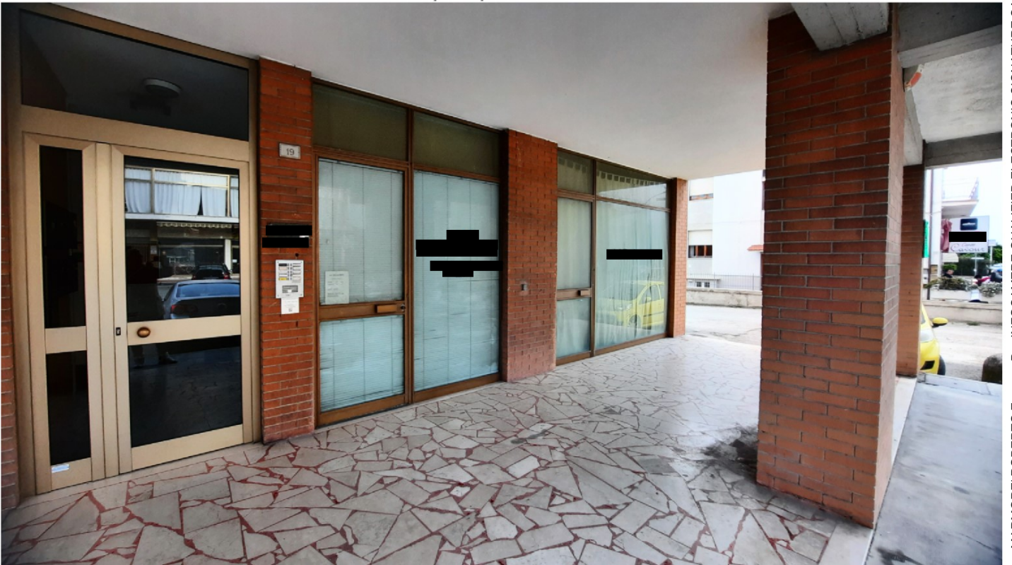
Foto 4 - prospetto est - vetrine
