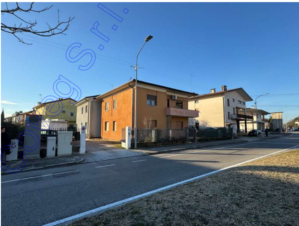
Foto 2 – vista fabbricato dalla viabilità principale
