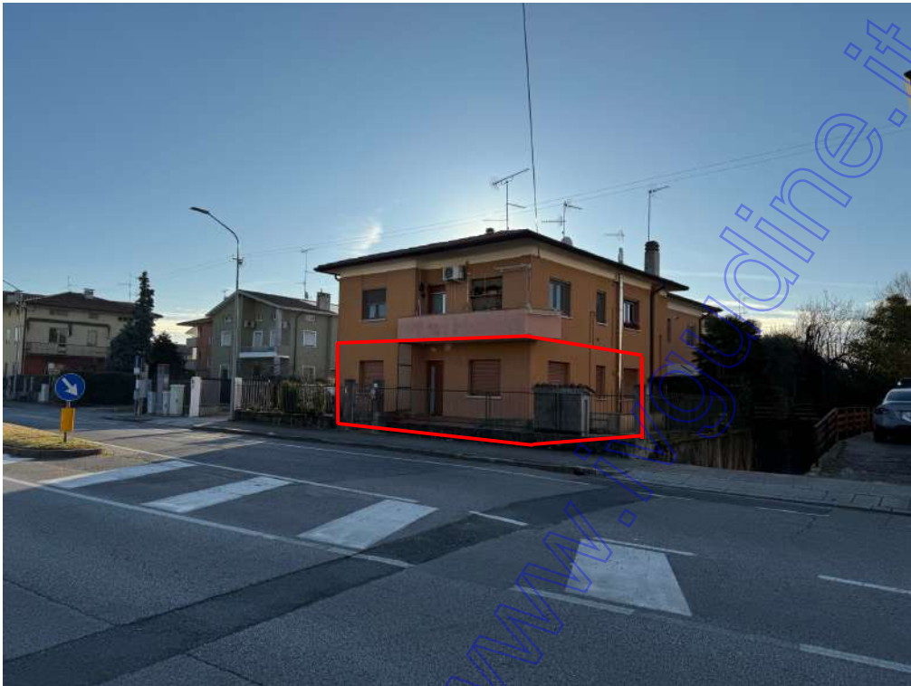
Foto 1 - vista fabbricato dalla viabilità principale
