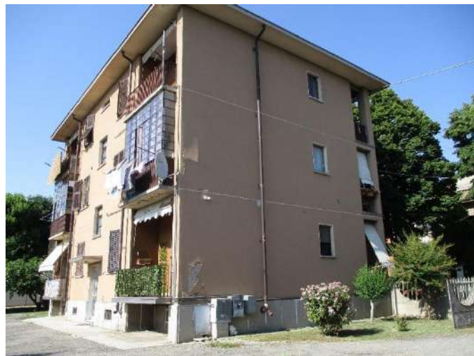
Vista dei prospetti verso la corte comune
