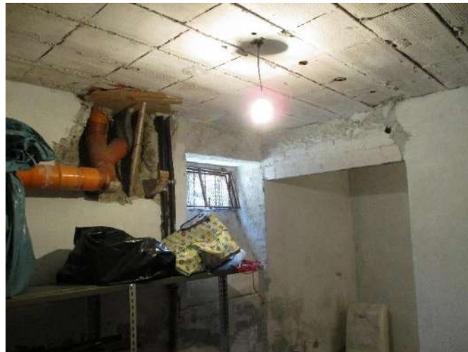
Vista della cantina piano semi – interrato
