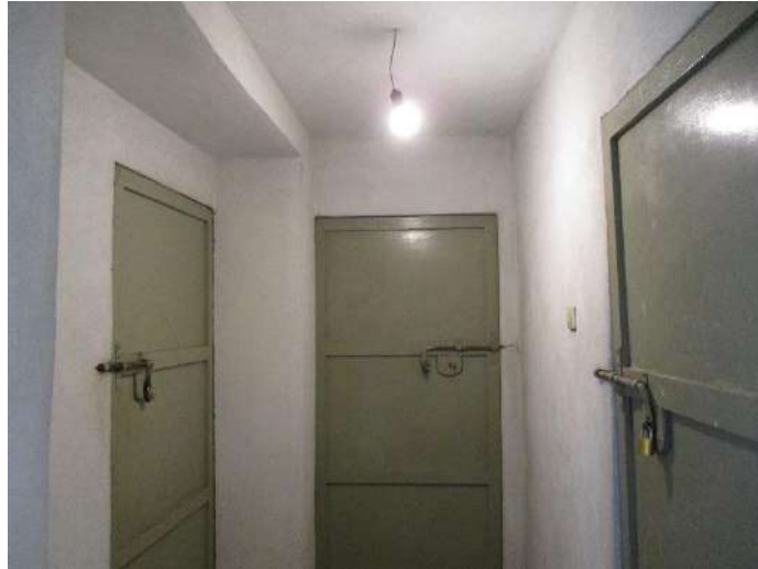
Vista dell'accesso alla cantina (porta al centro)
