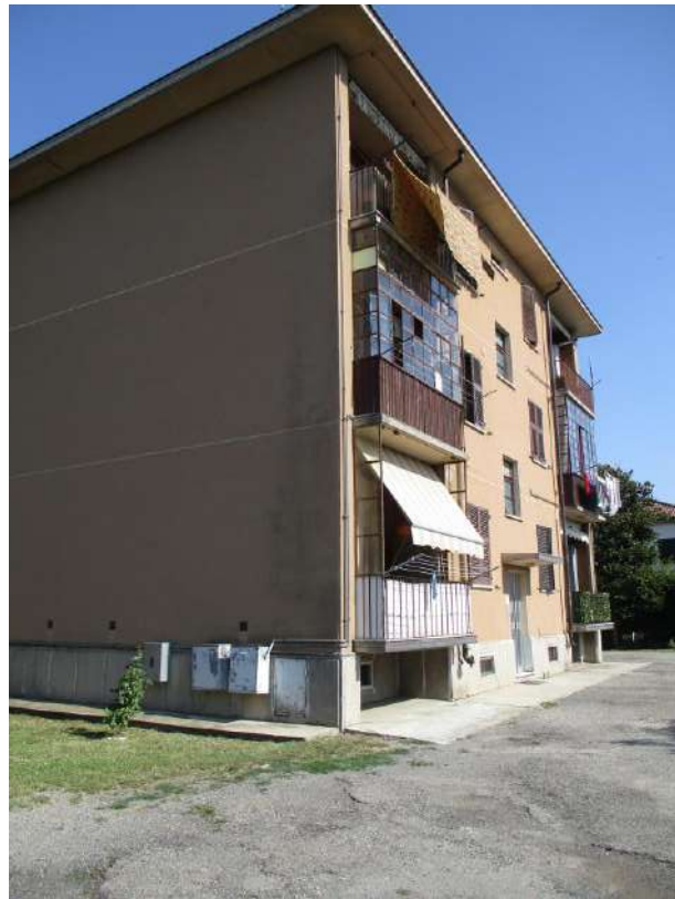
Vista dalla corte comune del balcone al piano 2° (nicchie contatori gas)
