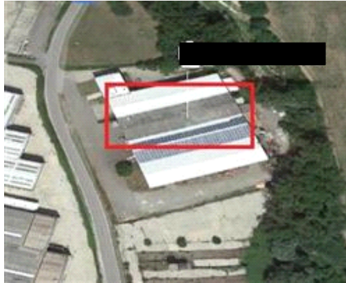
VISTA DALL'ALTO DELLA COPERTURA IN FIBRO-AMIANTO
