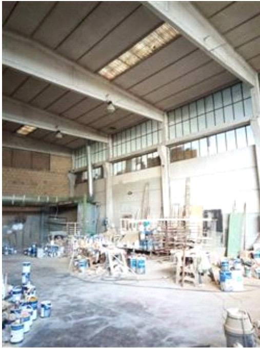
interno con evidenziata la struttura a capriata
