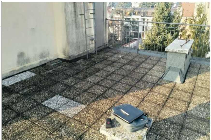
La pavimentazione in quadrotti di cemento
