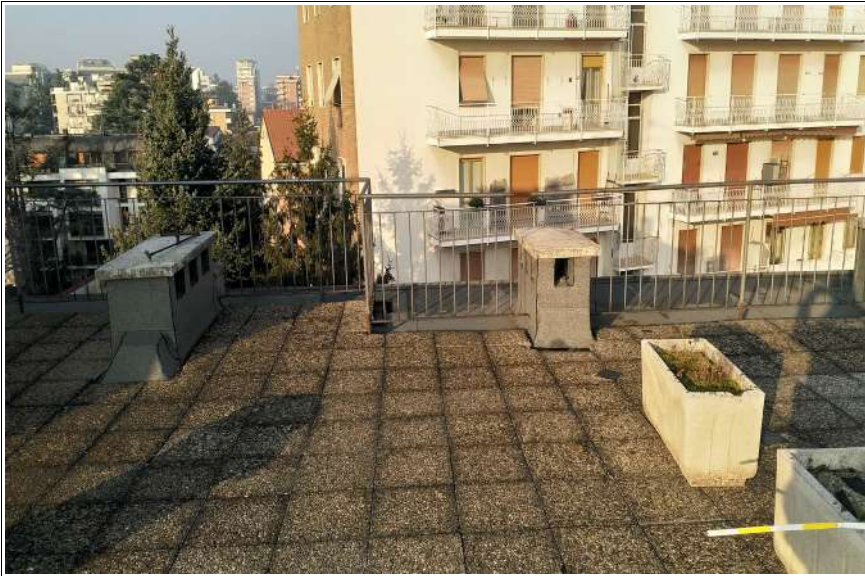
Il parapetto in ferro con particolari dei comignoli di esalazione e alcune fioriere in cemento.
