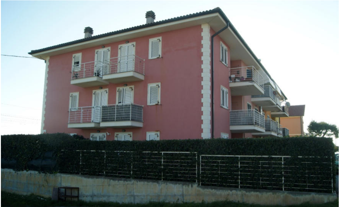
Veduta esterna edificio ove è posta la soffitta
