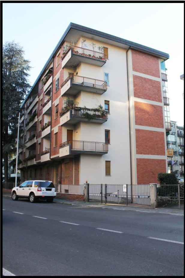
1. Il fabbricato nel suo complesso
