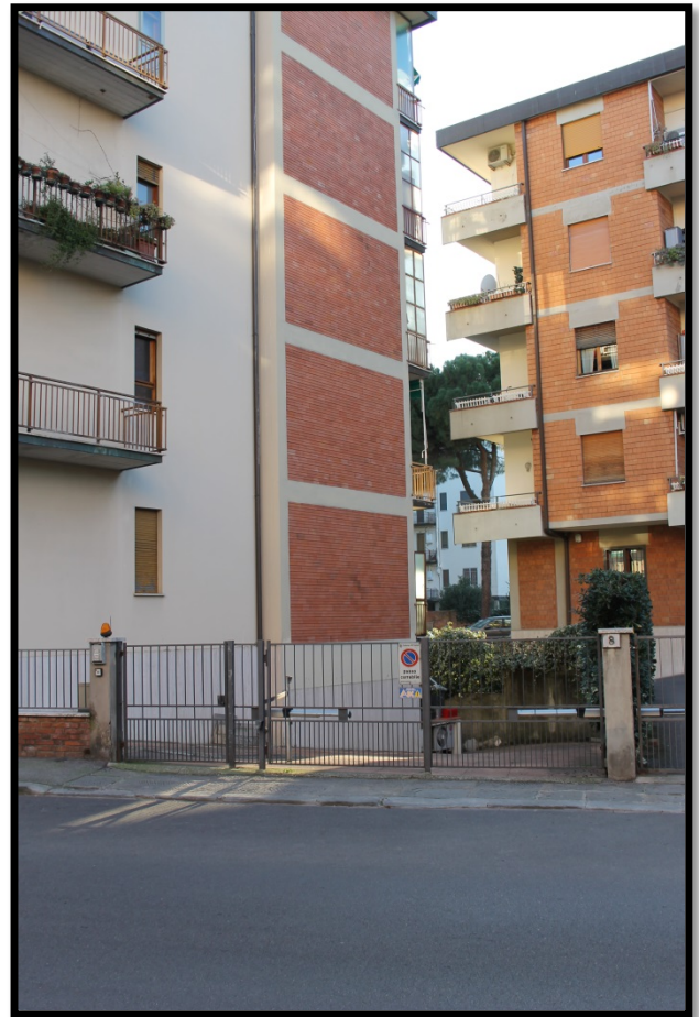
2. Cannello di accesso alla rampa verso il seminterrato
