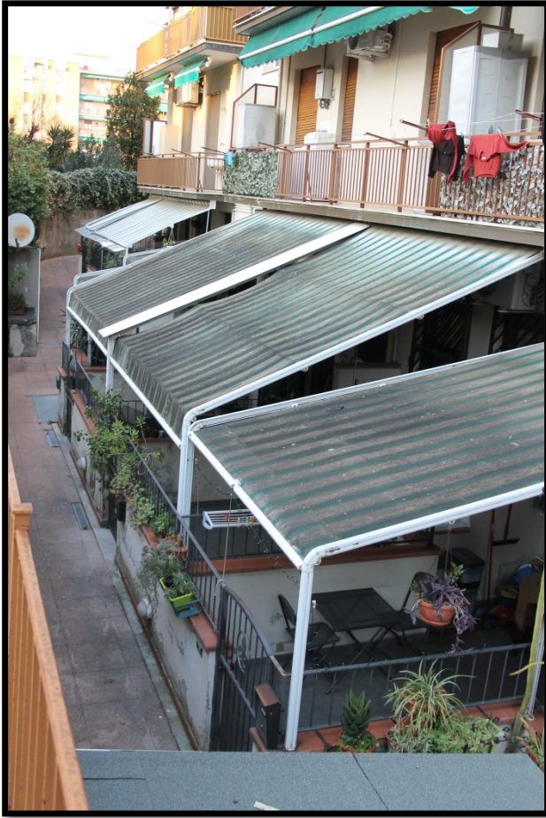
4. Vista dei resedi di ingresso agli appartamenti seminterrati coperti da tende da sole
