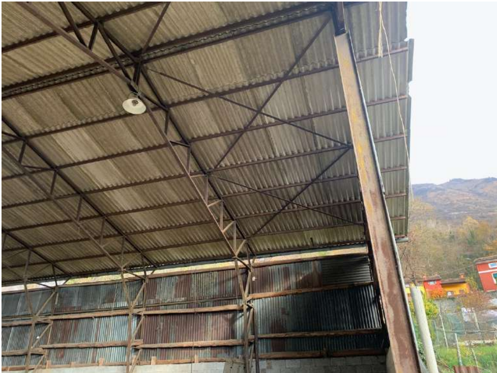
Deposito dettaglio copertura (eternit).
