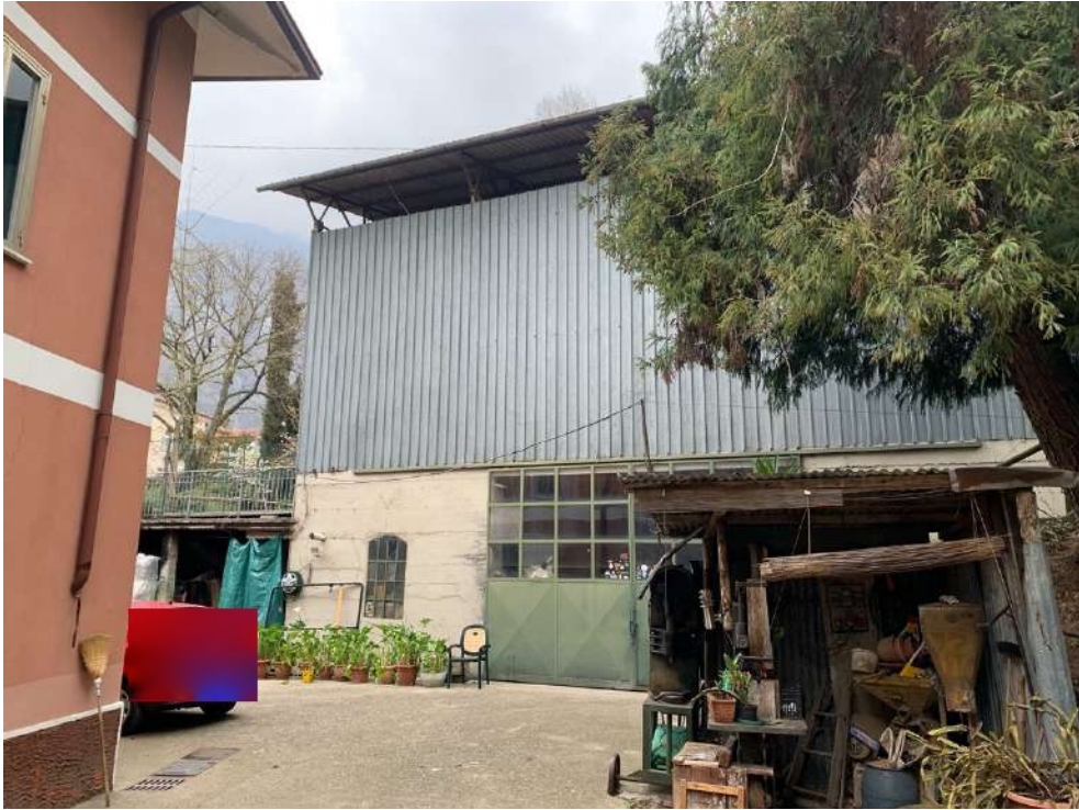
Deposito, lato sud.
