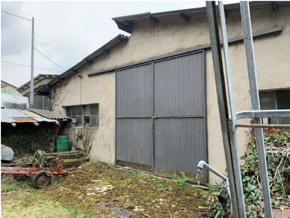
Deposito (ex stalla), lato nord.
