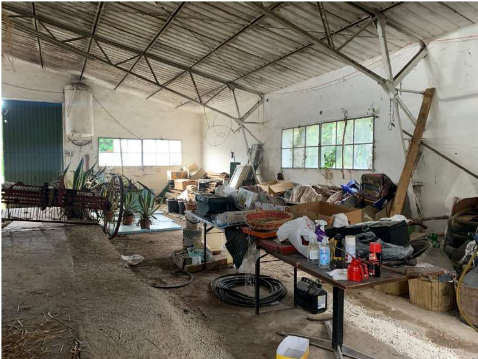
Interno deposito (ex stalla).
