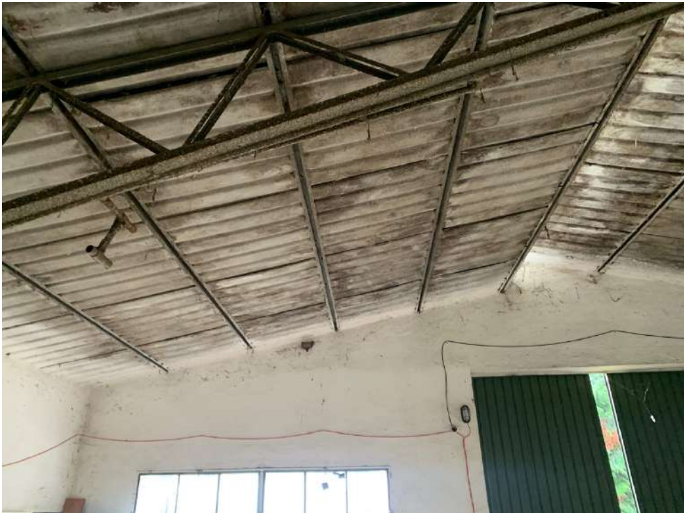
Interno ex stalla, dettaglio copertura (eternit).
