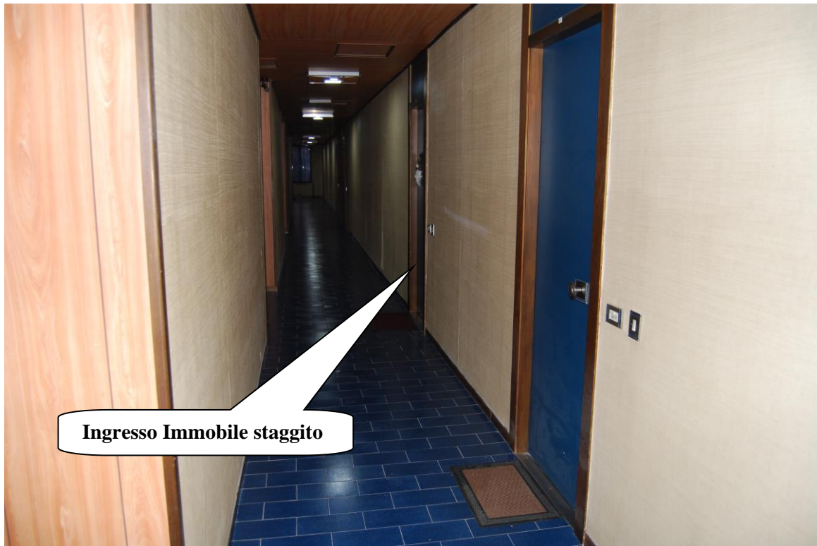
Foto n. 3 – Vista esterna, Ingresso all'Immobile staggito – Corridoio Condominiale
