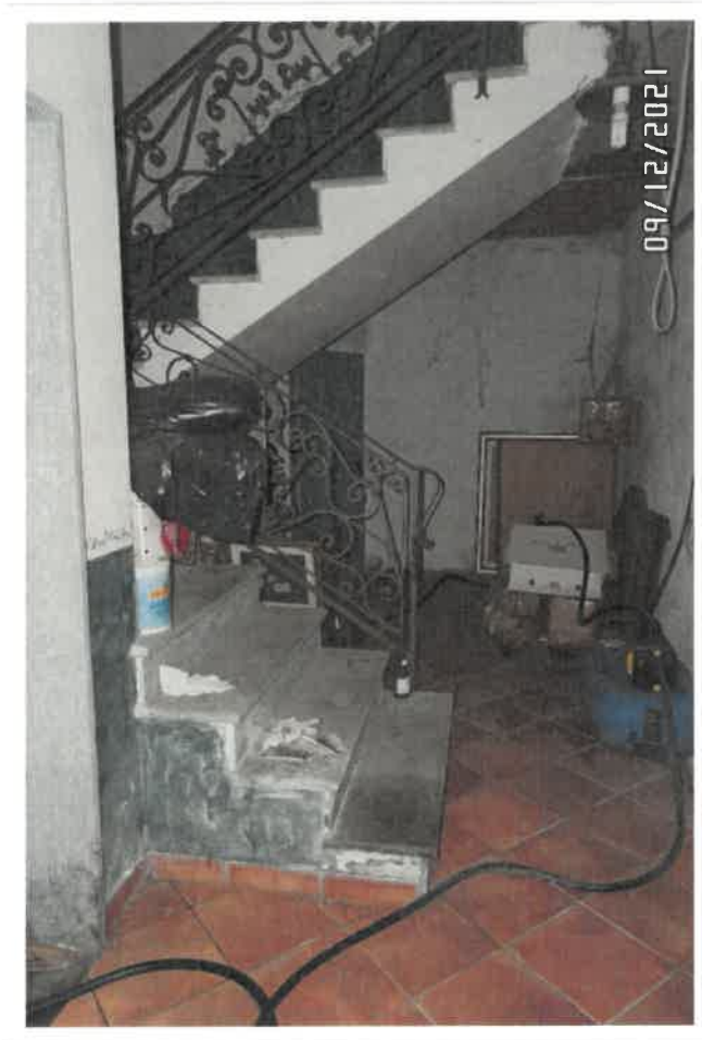
Scala interna Piano Sottostrada
