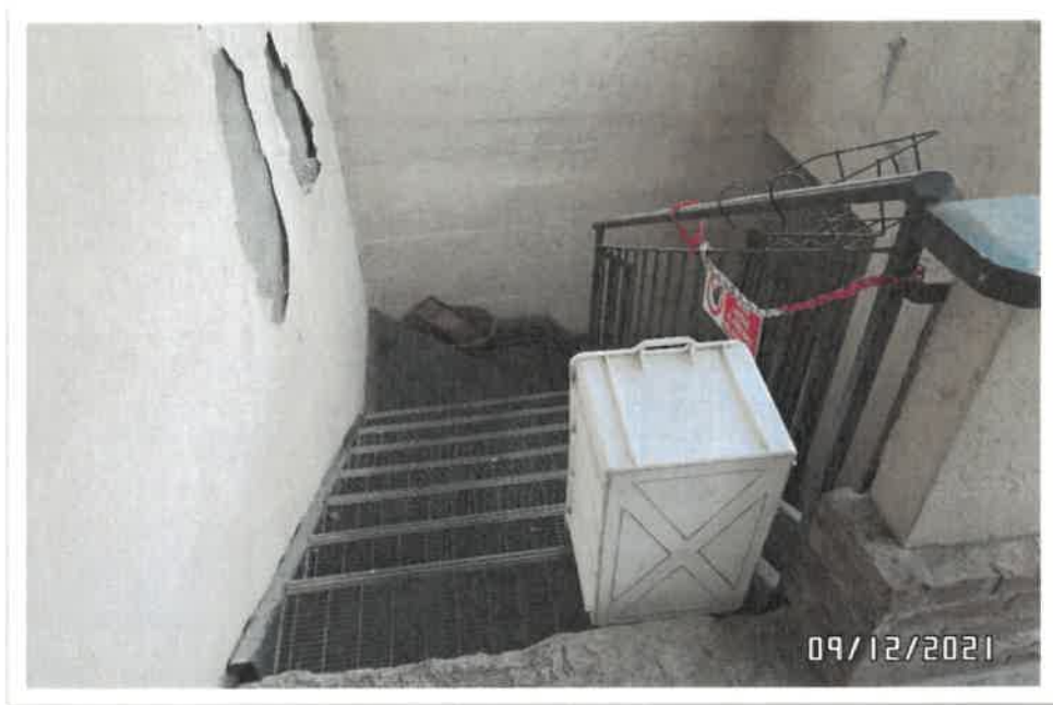
Scala esterna per accesso Piano Sottostrada
