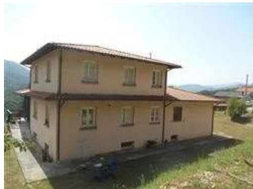
veduta del retro del bene oggetto di stima, lati nord est e nord ovest
