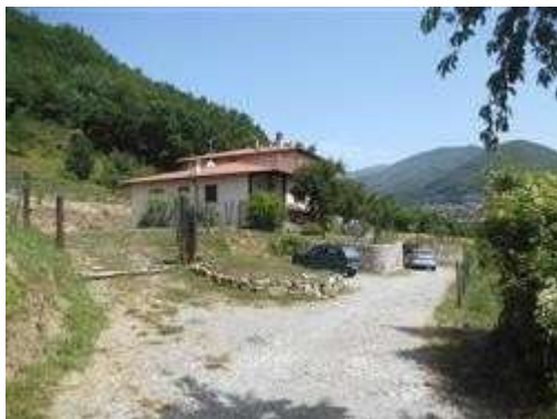
veduta dei beni oggetto di stima ripresa dalla pubblica via che serve la zona: l'unità immobiliare 992 sub. 1 si trova nella porzione di fabbricato su questo lato
