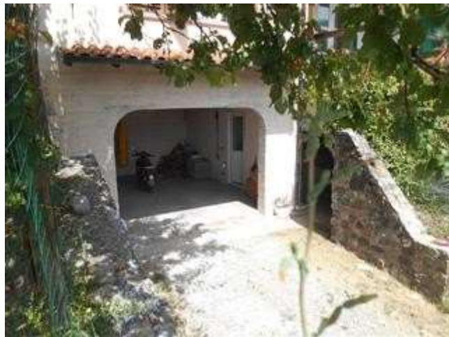
veduta del portone di ingresso all'unità immobiliare 992 sub. 3 (privo di serramento) con terreno pertinenziale
