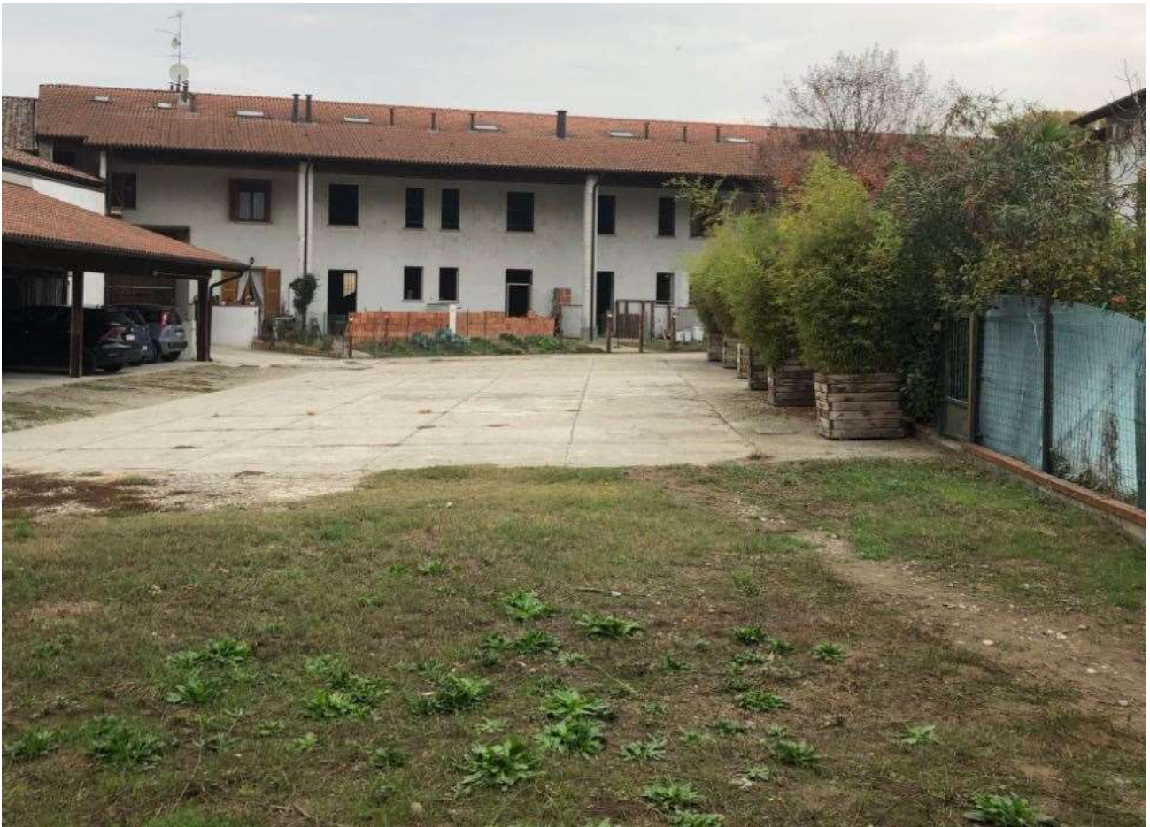
Fig. 1. Vista del complesso dalla corte interna
