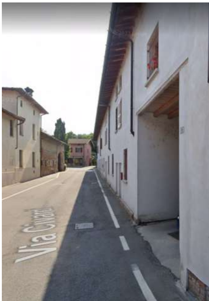
Figg. 1-2. Vista del complesso dalla Via Civardi
