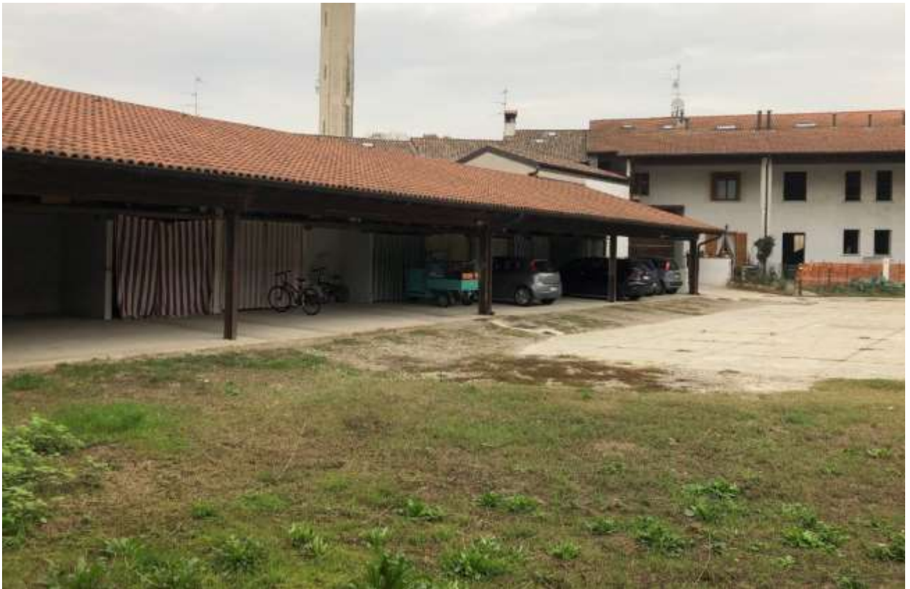
Fig.12. Vista del complesso dalla corte interna
