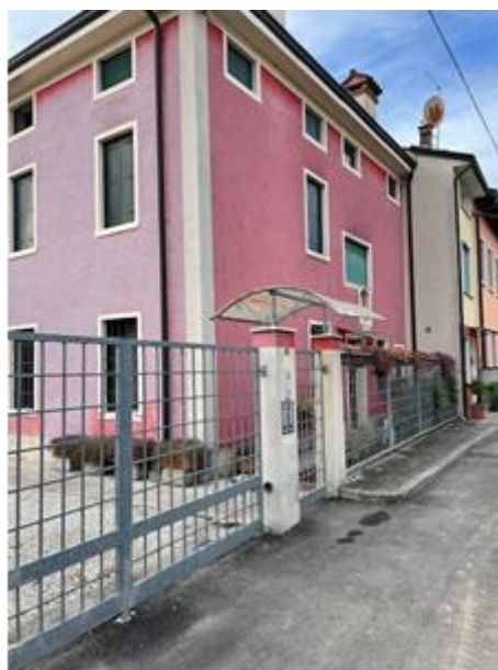
Foto n. 2 ingresso carraio da Via Tomasina
