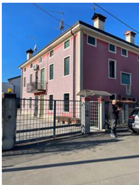
Foto n. 1 ingresso pedonale da Via Tomasina
