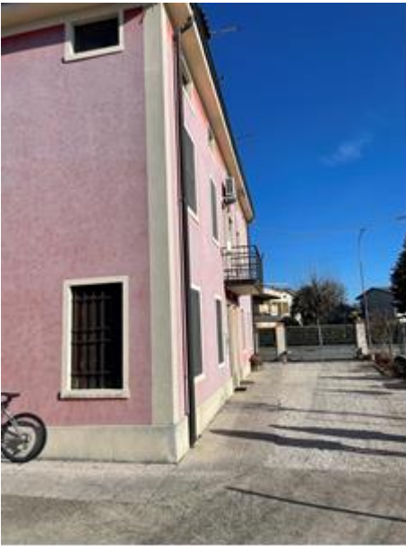
Foto n. 3 retro fabbricato lato ovest
