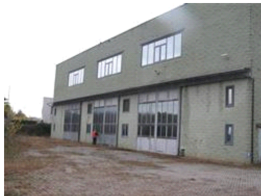
Vista esterna - Laboratorio
