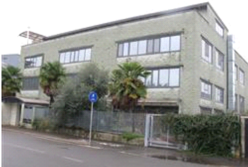
Vista esterna - Laboratorio
