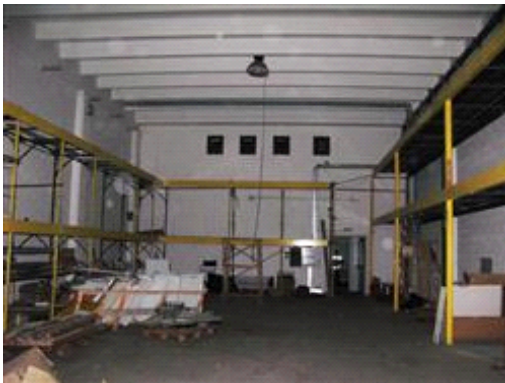
Vista interna – Magazzino PT
