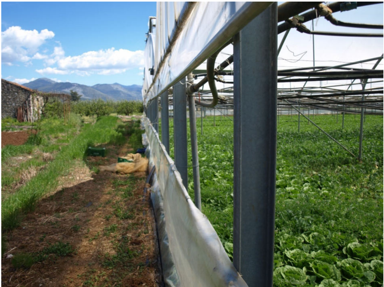
LATO POSTERIORE SERRE-OPPOSTO ALLA VIA VICINALE
