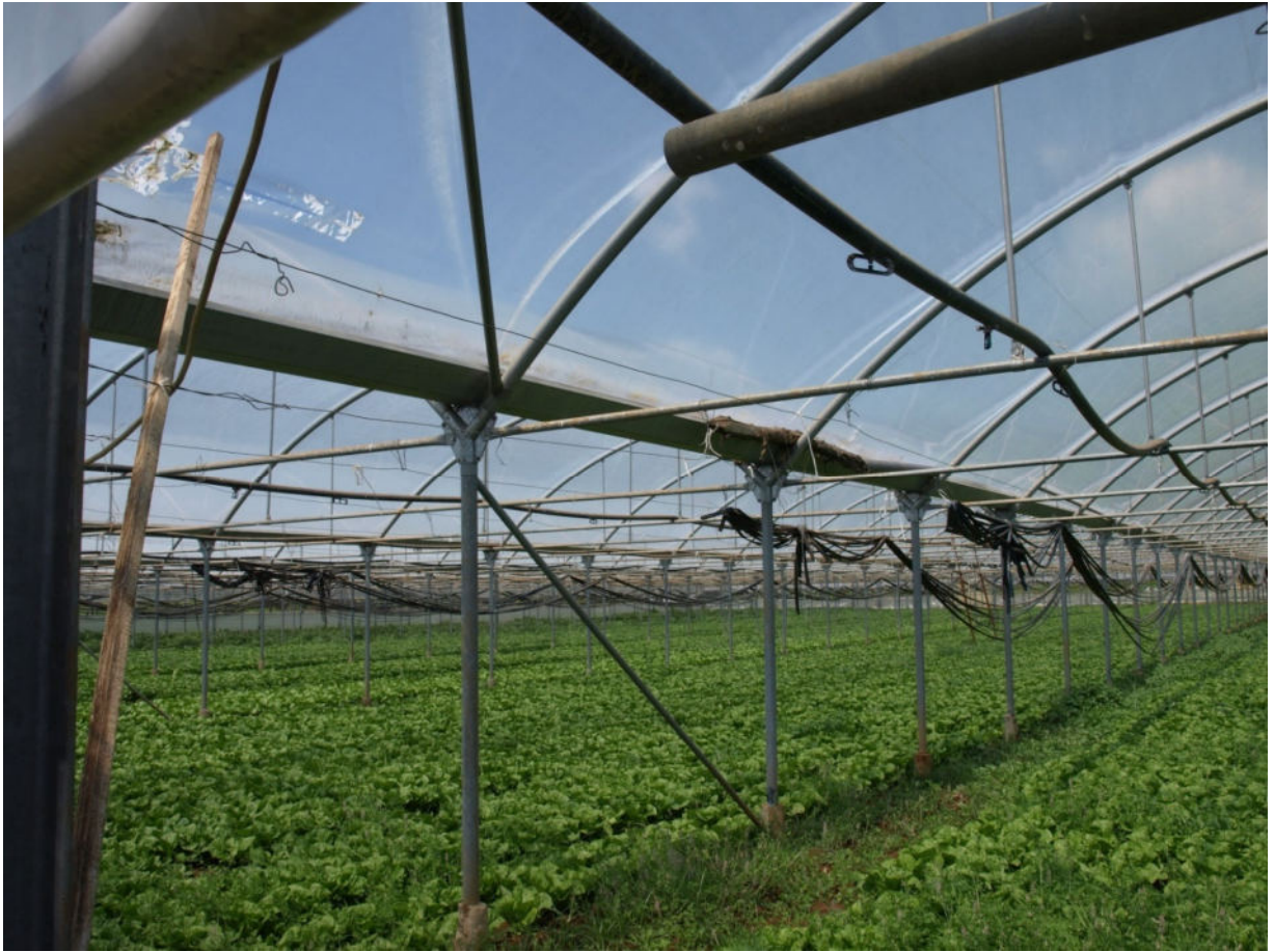
PARTICOLARE STRUTTURA METALLICA
