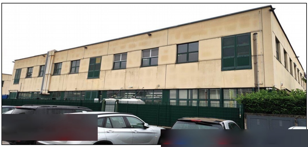
Vista facciata lato nord del complesso immobiliare
