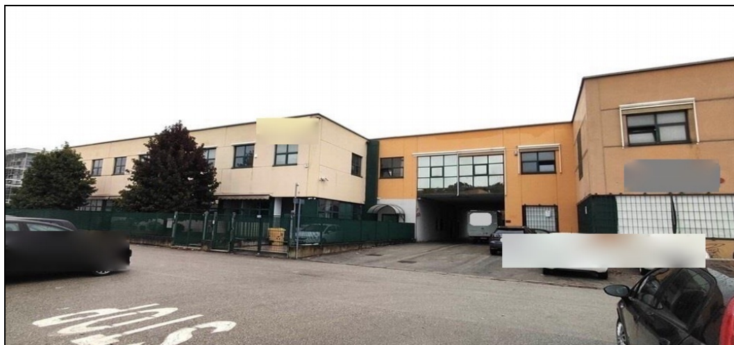
Vista facciata d'ingresso lato est
