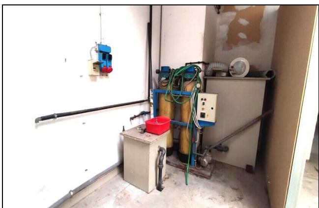
Stanza 20 – ex depurazione acque
