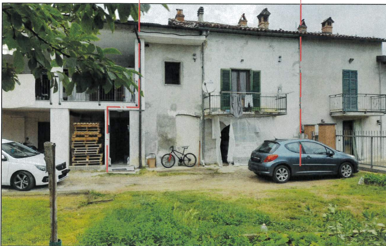
foto 1: veduta prospetto Sud
