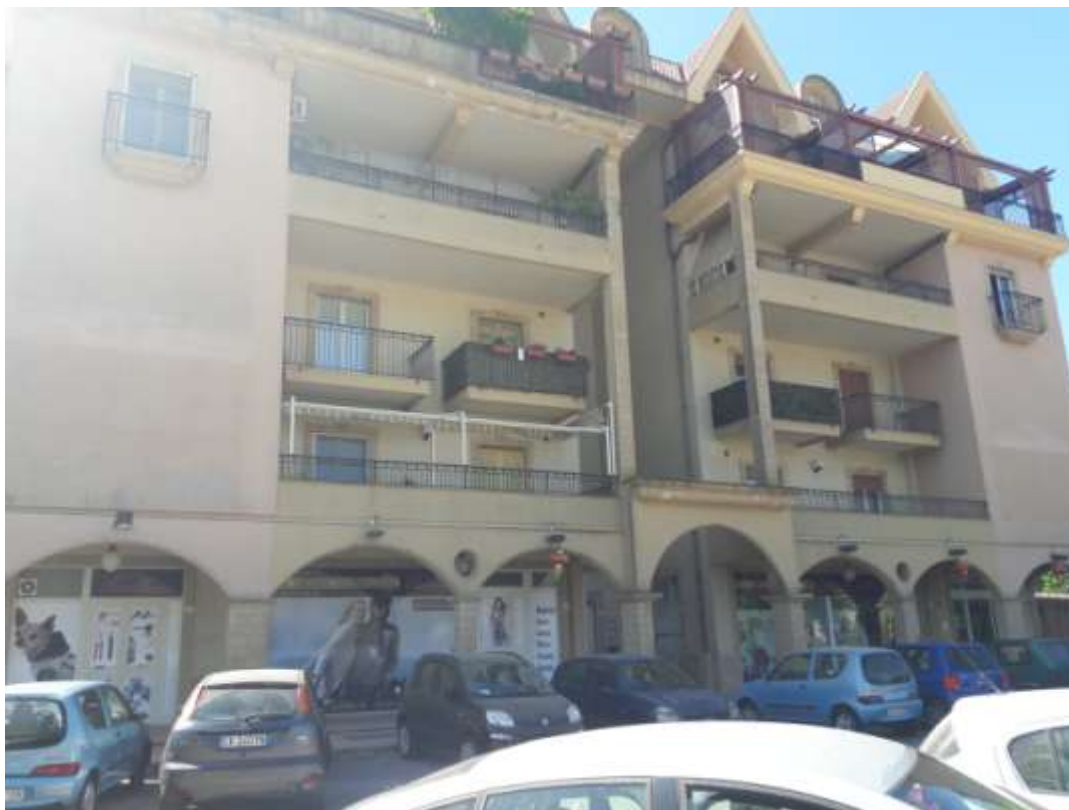
Foto 3 – Vista prospetto da via Boris Giuliano
