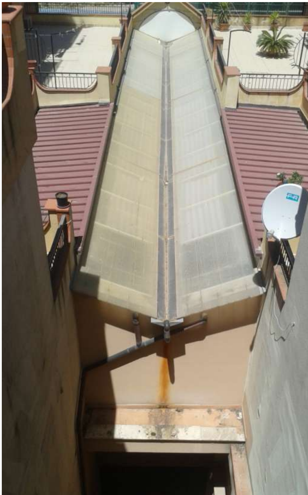
Foto 7 – Vista copertura a terrazzo e in plexiglass e lamierino
