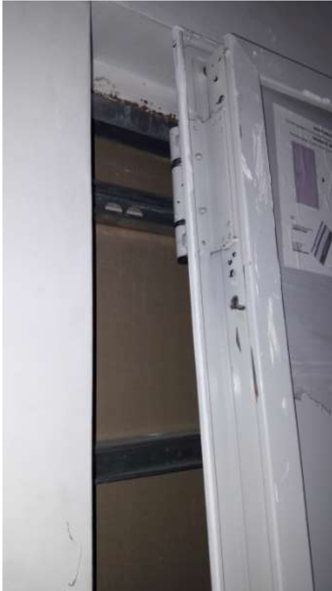
Foto 36 – Vista particolare della porta di comunicazione tra negozio e locale deposito
