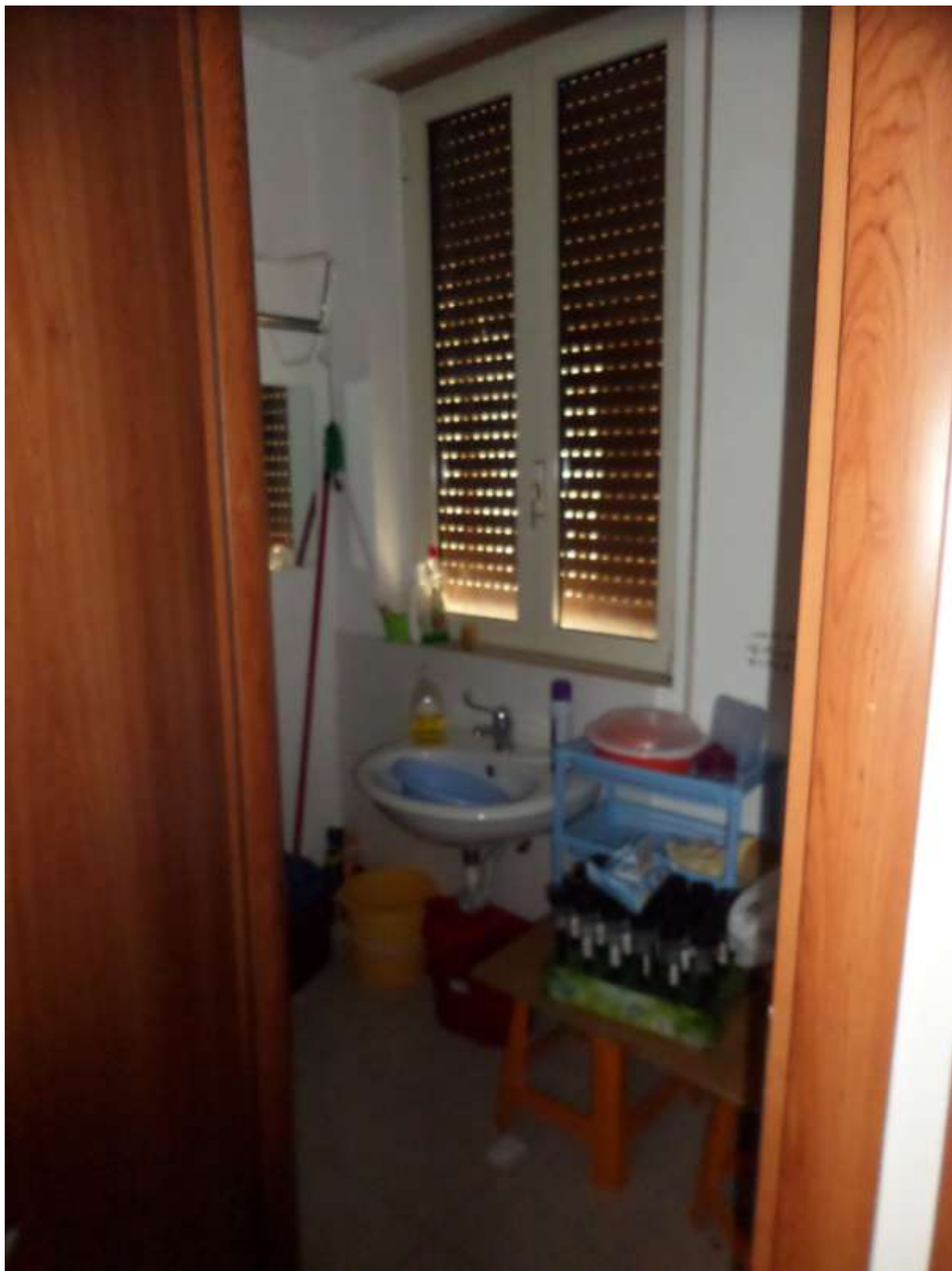
Foto 27 – Vista della zona antibagno 3 e tipologia di infissi
