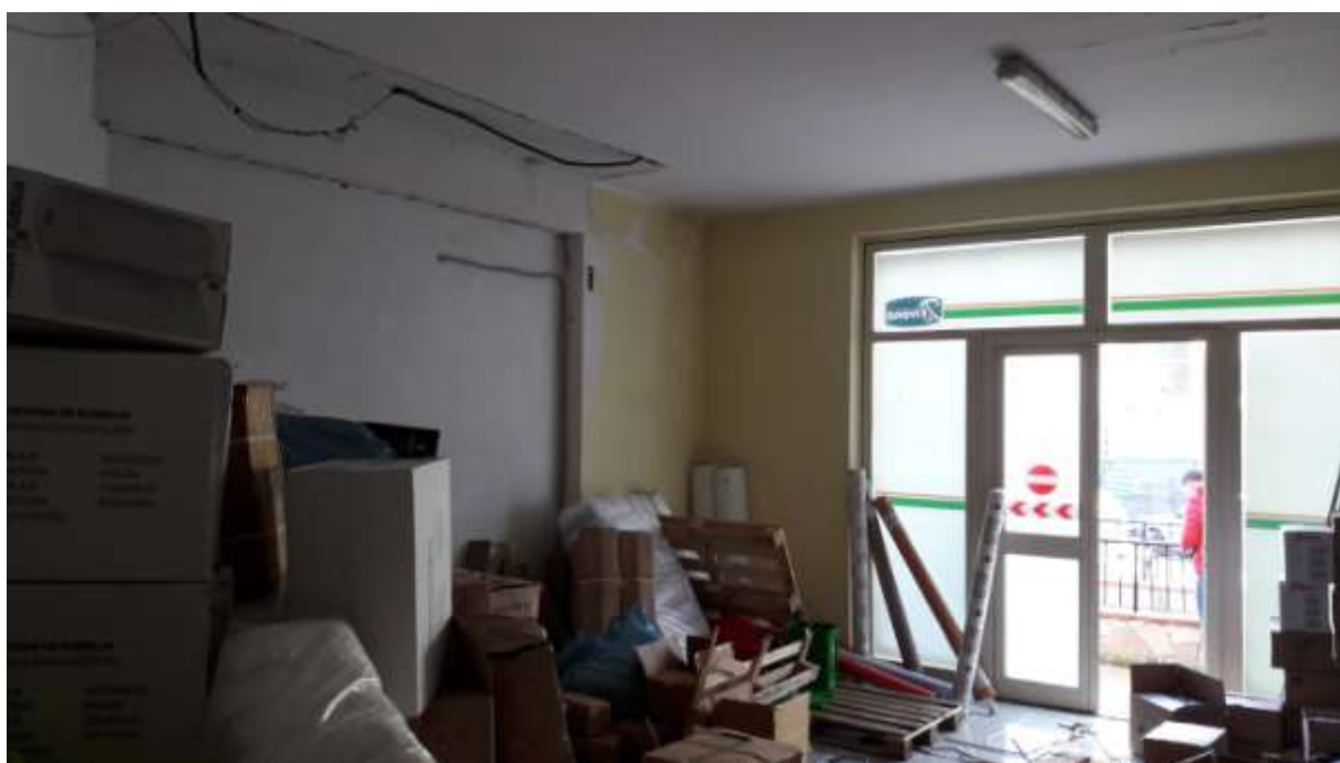
Foto 35 – Vista vano deposito, lato opposto alla porta
