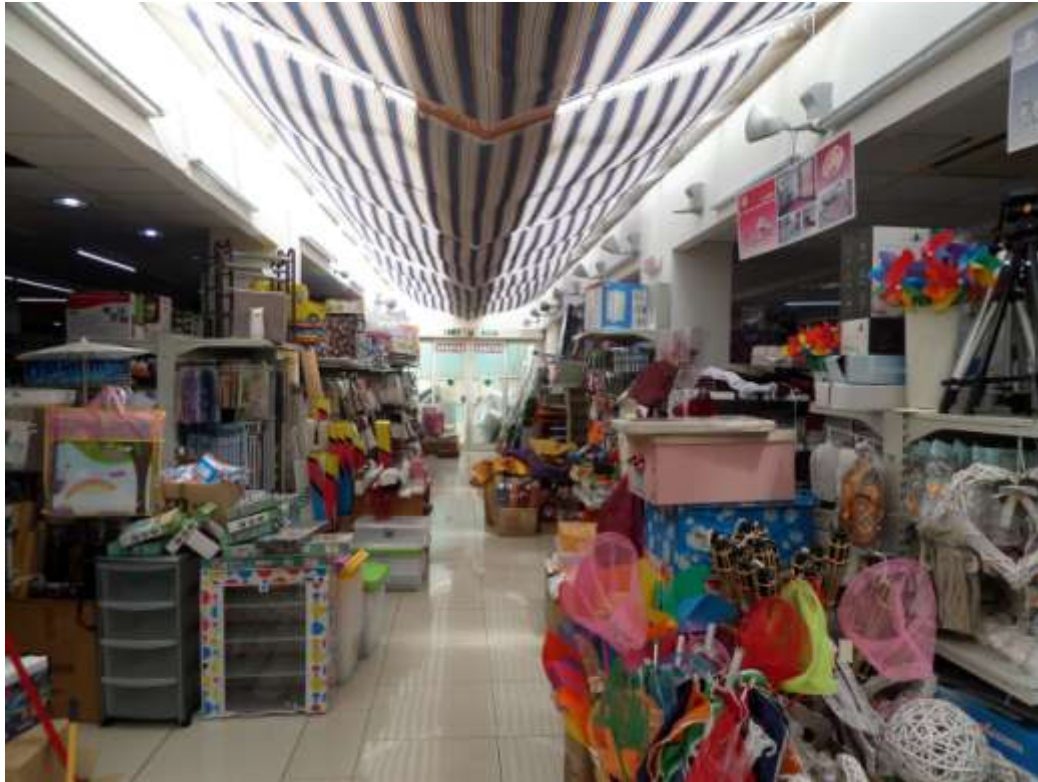
Foto 8 – Vista interna della copertura in plexiglass con ex-ingresso frontale dal civico 15/E
