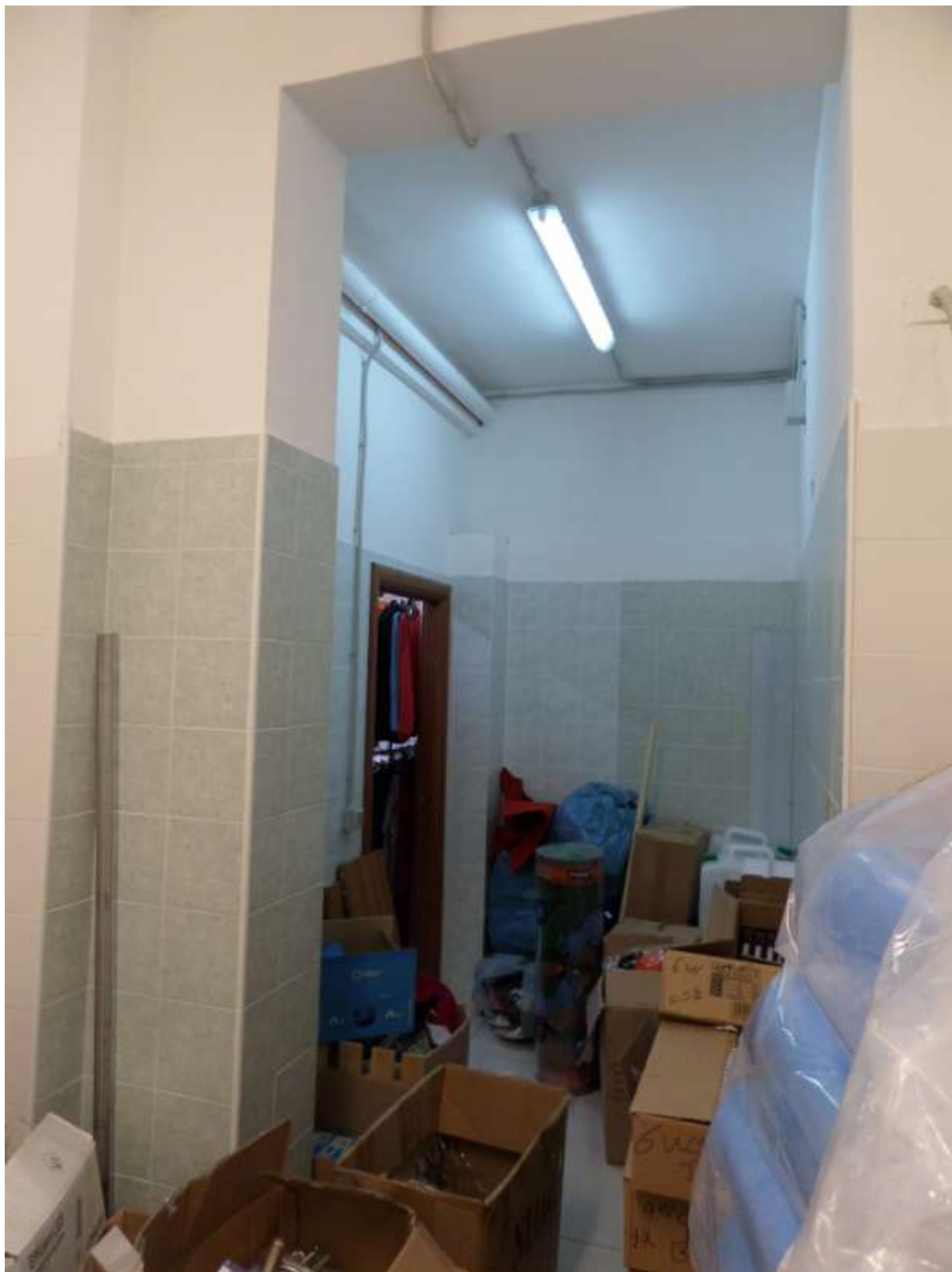
Foto 31 – Vista vano laboratorio – lato muro
