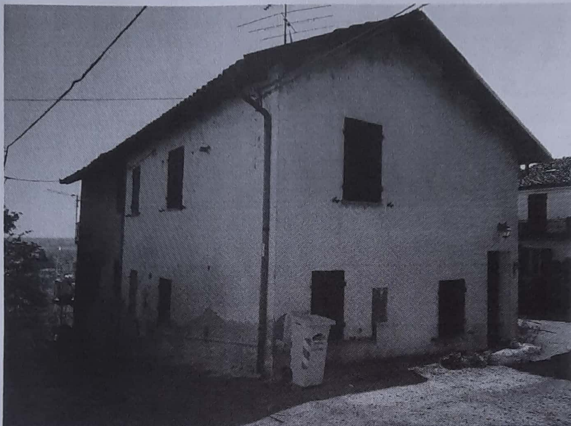
Foto n. 1 _Prospetti Nord ed Ovest
