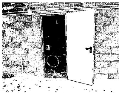
dalla rampa e dalla corsia condominiale, ha la porta tagliafuoco di accesso, la pavimentazione in cemento la tamponatura in blocchi faccia vista ed è completa di impianto elettrico
