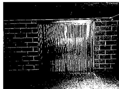
porta basculante di accesso in metallo, la pavimentazione in cemento, la tamponatura in blocchi faccia vista ed è completo di impianto elettrico.
