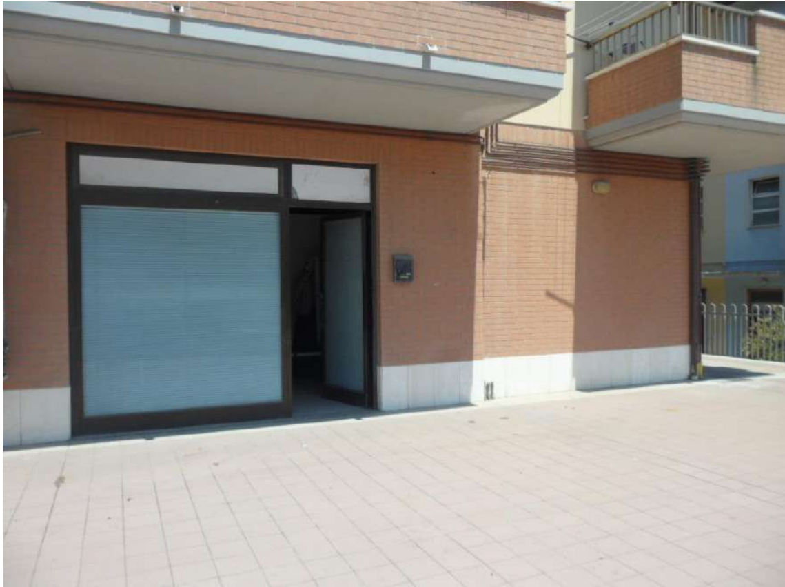
Foto 51 –Corte sud: ufficio part. 138/75 (Lotto 34)
