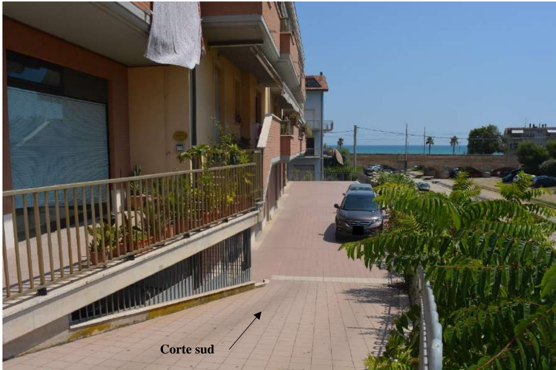
Foto 23 –Corte sud (part. 138/59) di accesso alle partt. 138/11, 138/73, 138/74, 138/75
