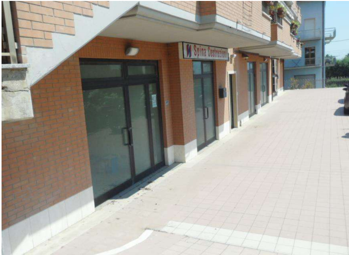
Foto 25 –Condominio Spina: corte sud con accesso all'ufficio part. 138/73 e part. 138/75
