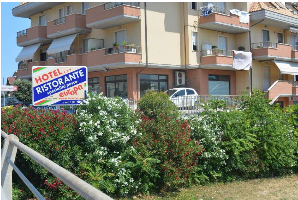
Foto 3 – Fabbricato “Condominio Spina” Via Foscolo (Parete sud)
