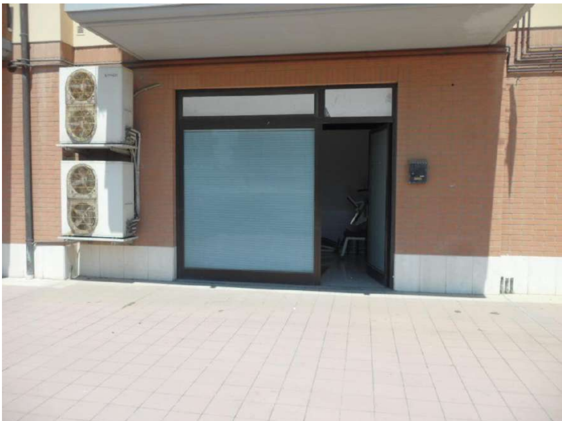
Foto 50 –Corte sud: ufficio part. 138/75 (Lotto 34)
