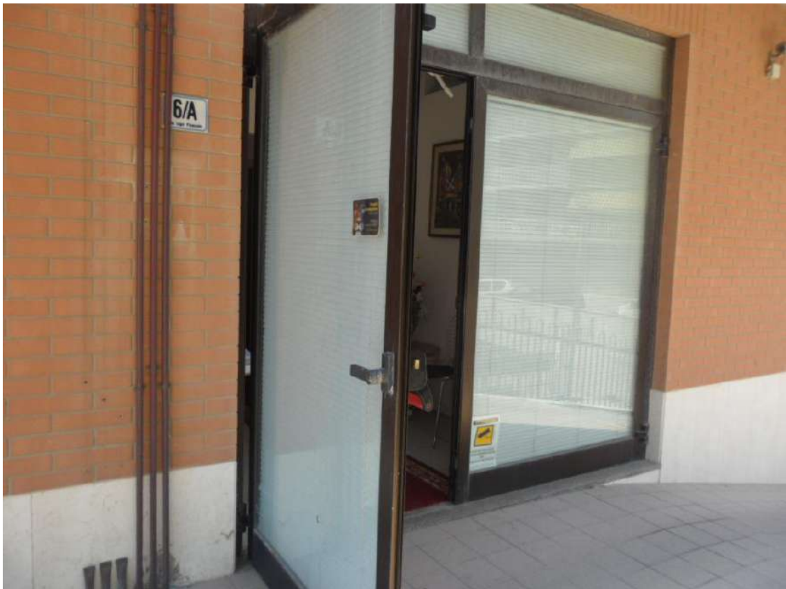
Foto 66 – Corte est: ingresso ufficio part. 138/74 (Lotto 33)
