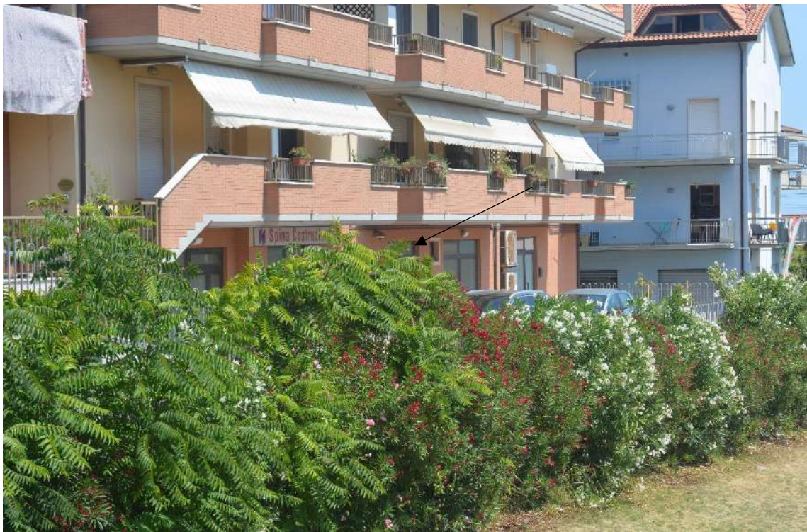
Foto 2 – Fabbricato “Condominio Spina” Via Foscolo (Parete sud)
