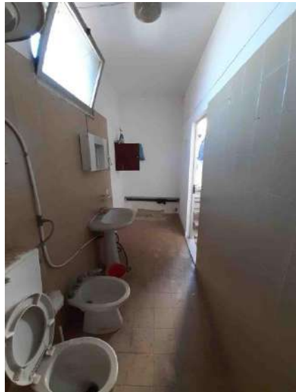
Foto 29 – Servizio igienico (WC1)
