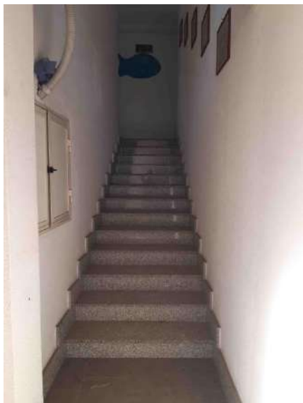
Foto 22 – Scala di accesso al 1° Piano (D1)
