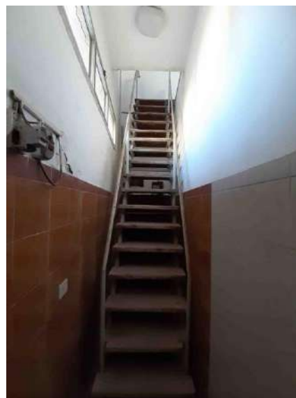
Foto 22 – Scala di accesso al 1° piano
