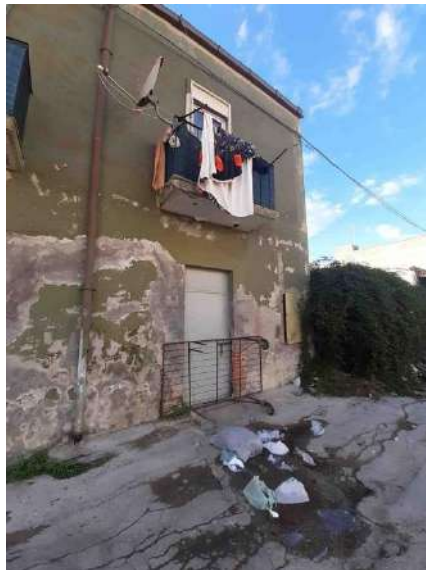
Foto 2 – Fabbricato Via Marina Ponente, 96
