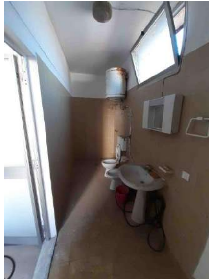
Foto 28– Servizio igienico (WC1)
