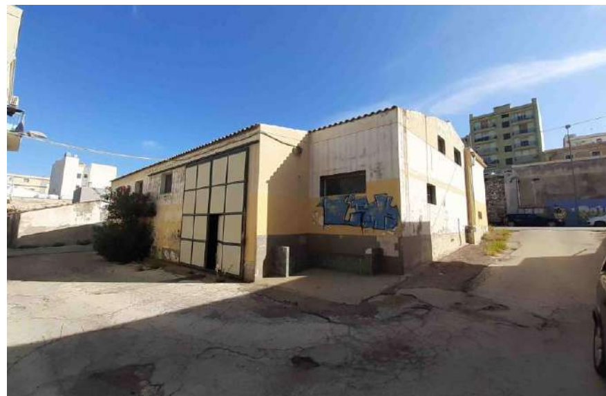
Foto 5 – Accesso da Vicolo Vega (carico e scarico merci)
