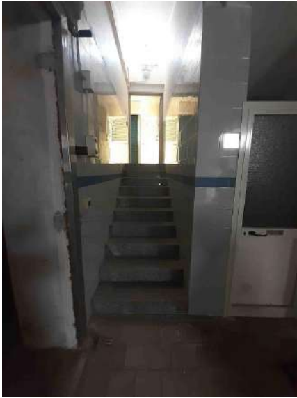
Foto 14 – Scala verso accessi Via Marina di Ponente
