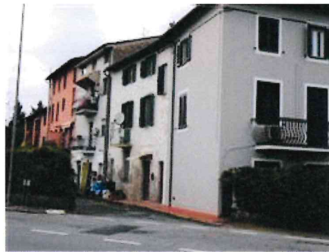
vista ingresso alla corte
