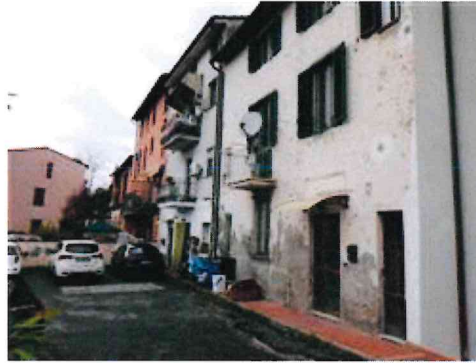
vista dei fabbricati a schiera
