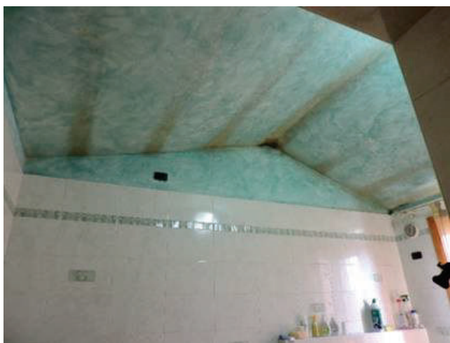
Foto 17 Soffitto del bagno con fenomeni di muffa
