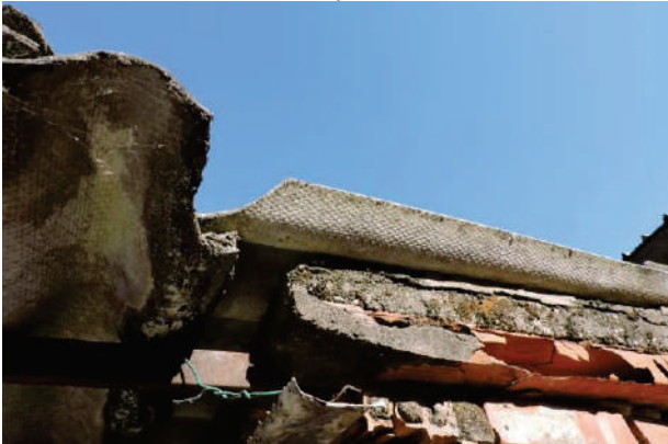
Foto 22 Lastre di copertura in cemento amianto
