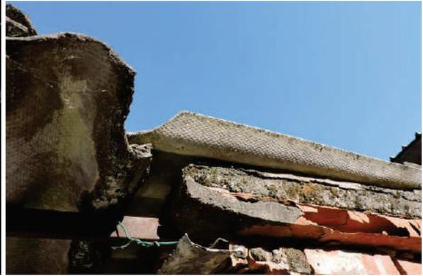
Foto 22 Lastre di copertura in cemento amianto
