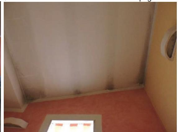
Foto 10 Muffe sul soffitto del vano scale
