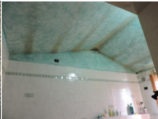
Foto 17 Soffitto del bagno con fenomeni di muffa
