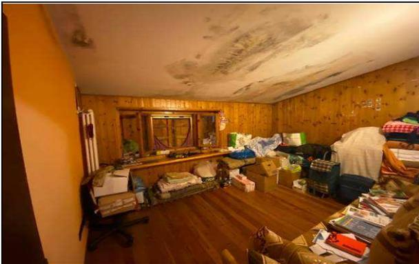
Camera (con tracce di infiltrazioni)
