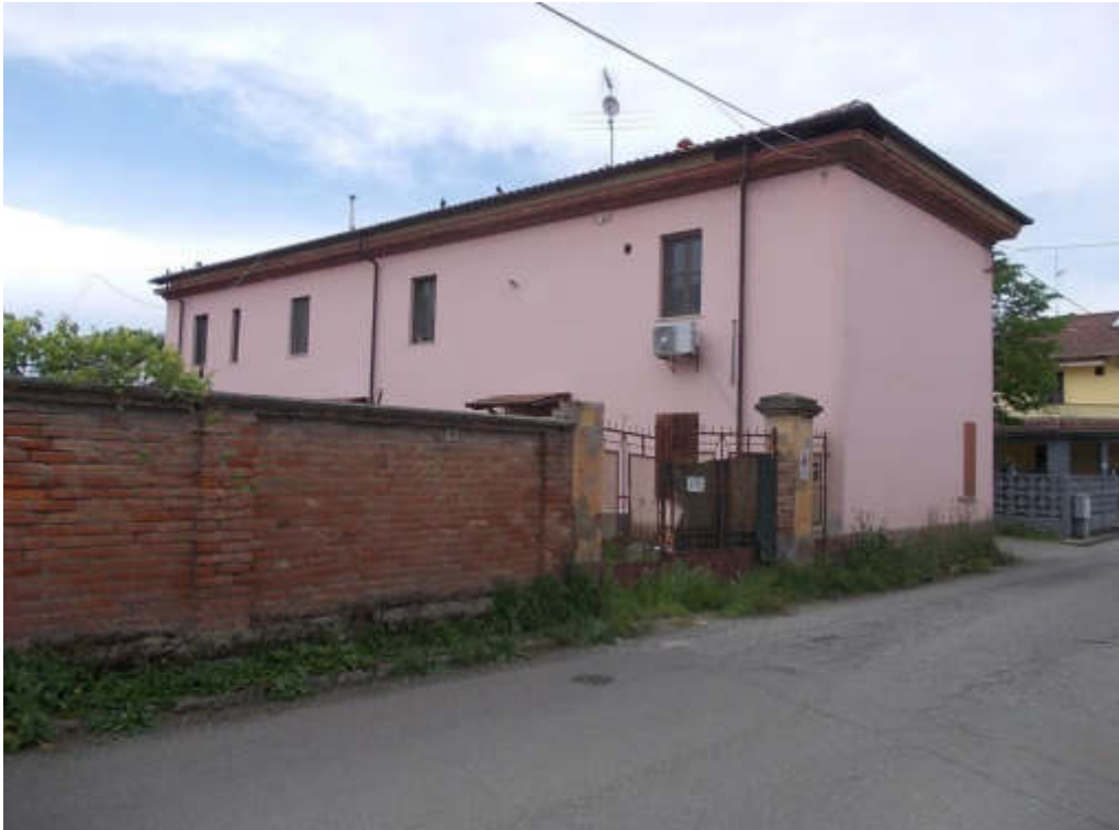
Foto 1 Prospetto sud/est fabbricato da strada
