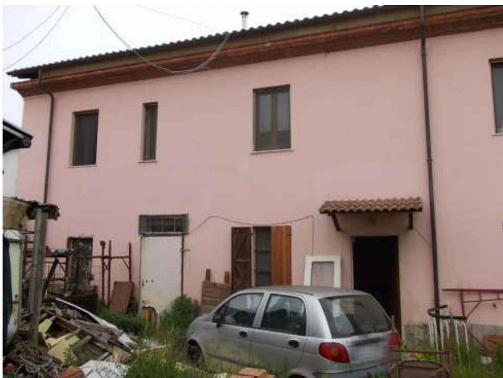
Foto 8 Prospetto sud fabbricato da interno cortile
