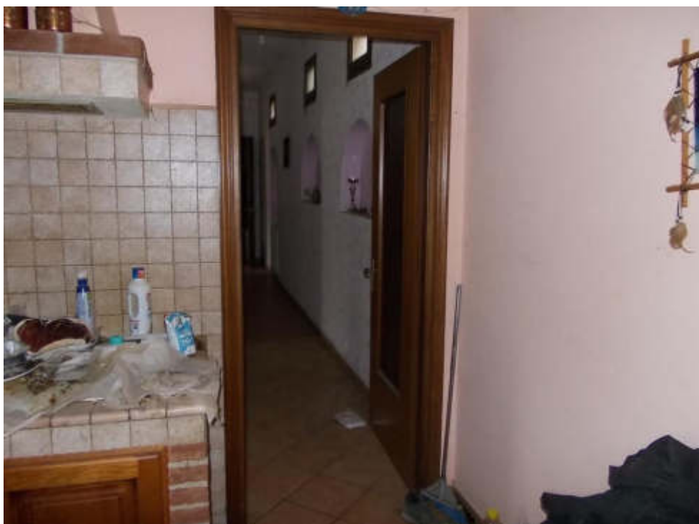
Foto 14 Corridoio piano primo
