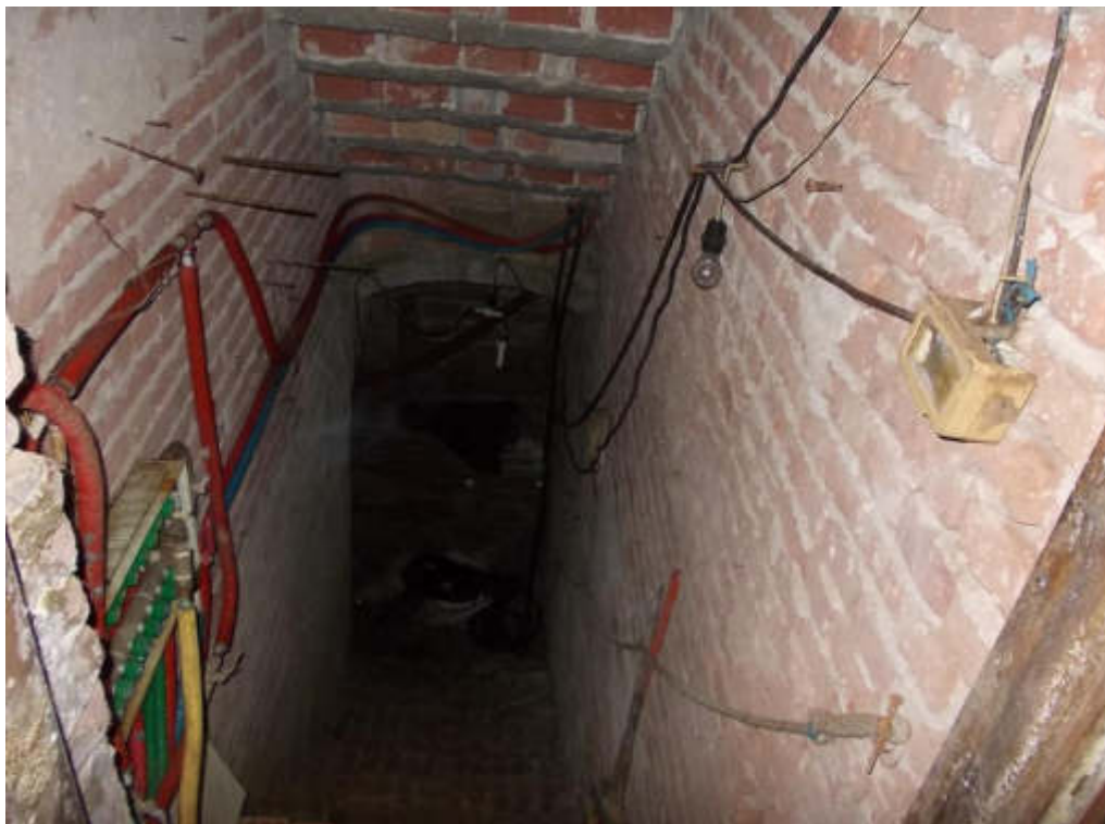
Foto 25 Cantina piano interrato
