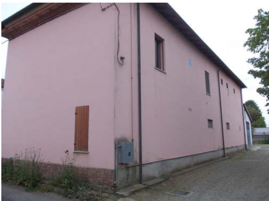
Foto 4 Prospetto nord/est fabbricato da strada
