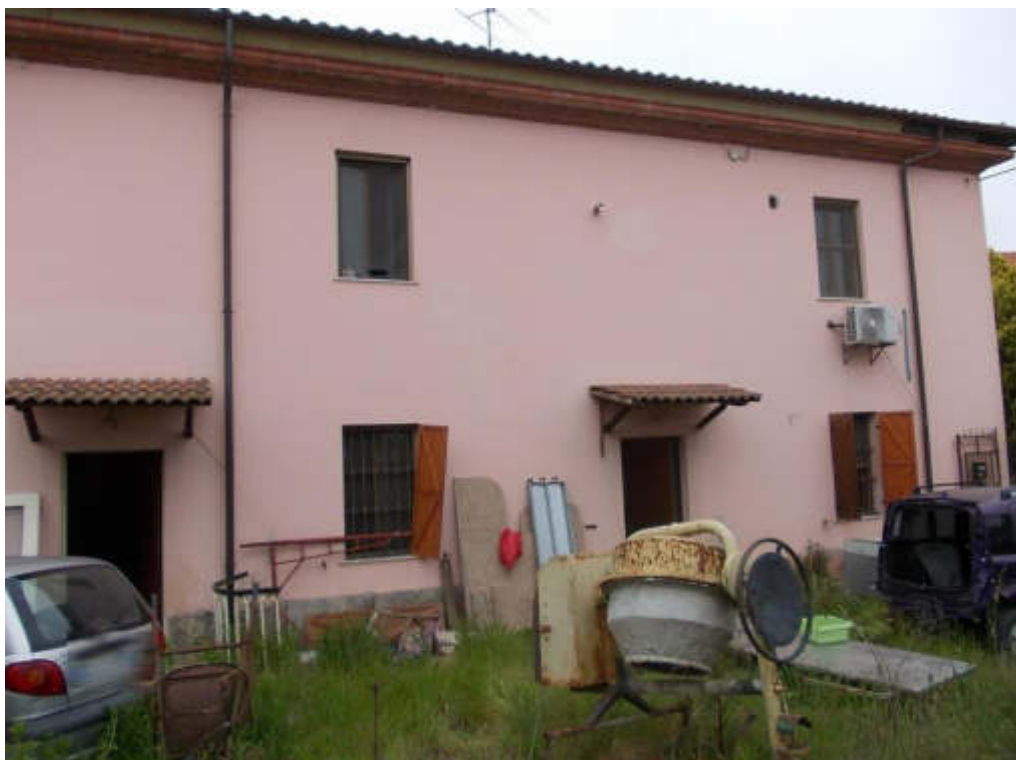
Foto 9 Prospetto sud fabbricato da interno cortile
