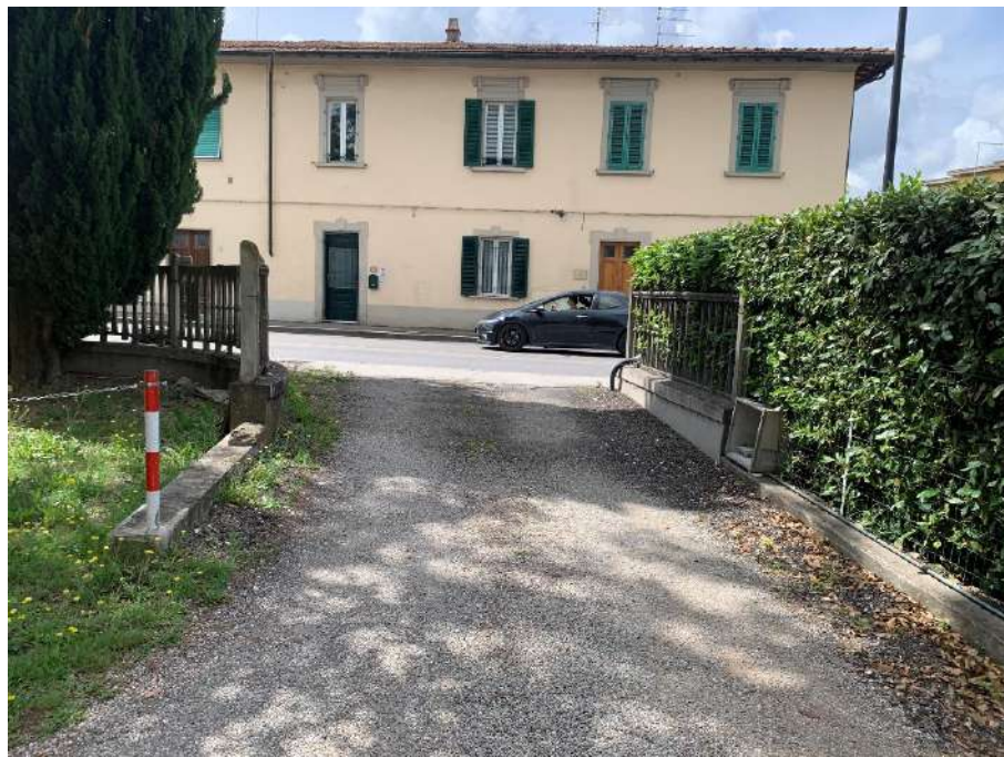
Foto n. 2 – Vista dell'accesso dalla pubblica via dal piazzale a comune
