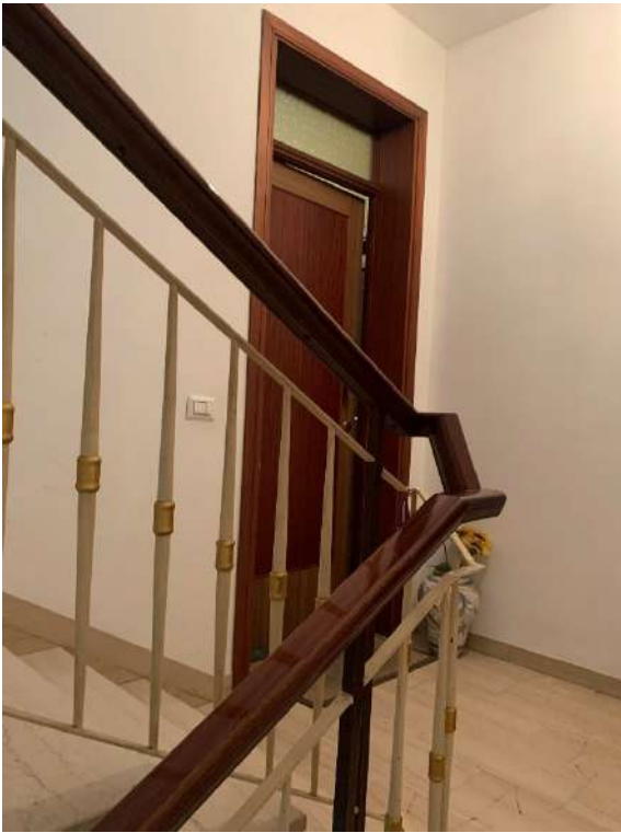
Foto n. 6 – Porta di accesso dal vano scale
