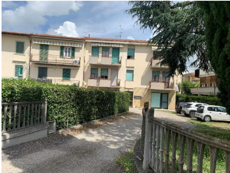
Foto n. 1 – Accesso dalla pubblica via battisti al cortile condominiale
