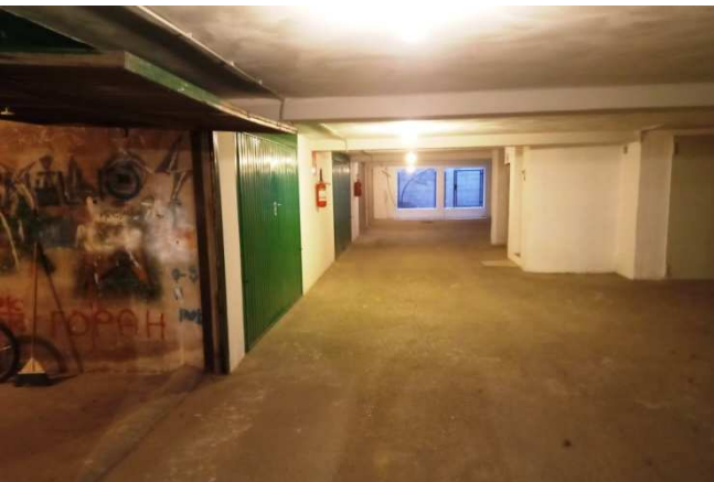
foto 20 - Vista da sud della corsia di manovra
