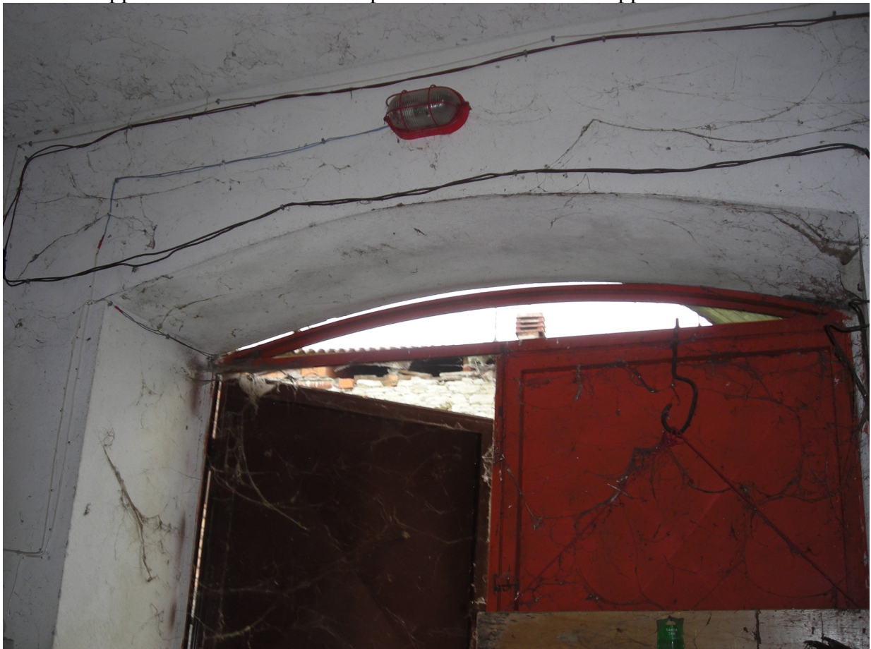
Lotto 2 Mappale 667 Box al P.T., interno
