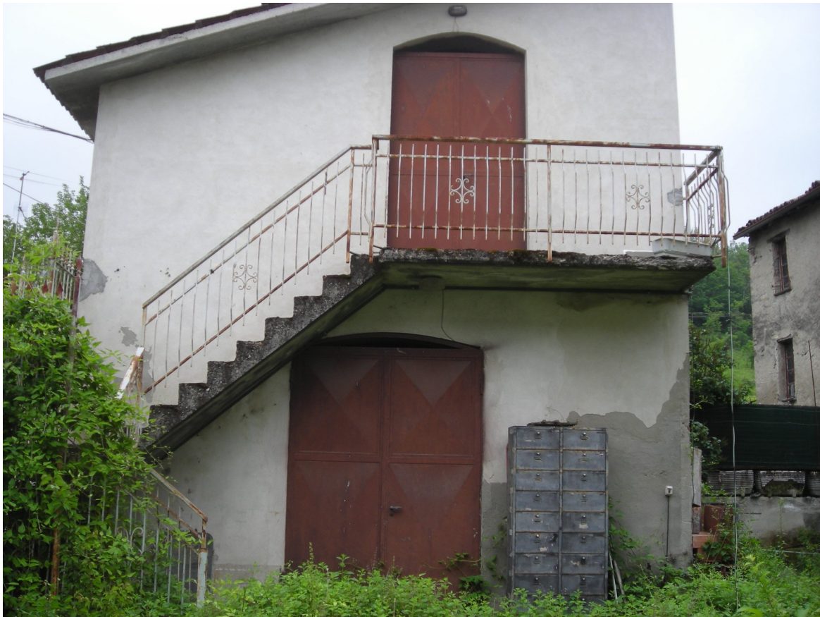
Lotto 2 Mappale 667 Box al P.T. e deposito al P1– vista da Mappale 671
