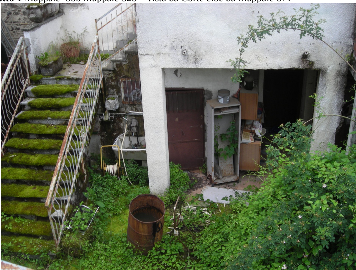
Lotto 1 Particolare della scala di accesso al Mappale 669 – vista da pianerottolo del Mappale 667
