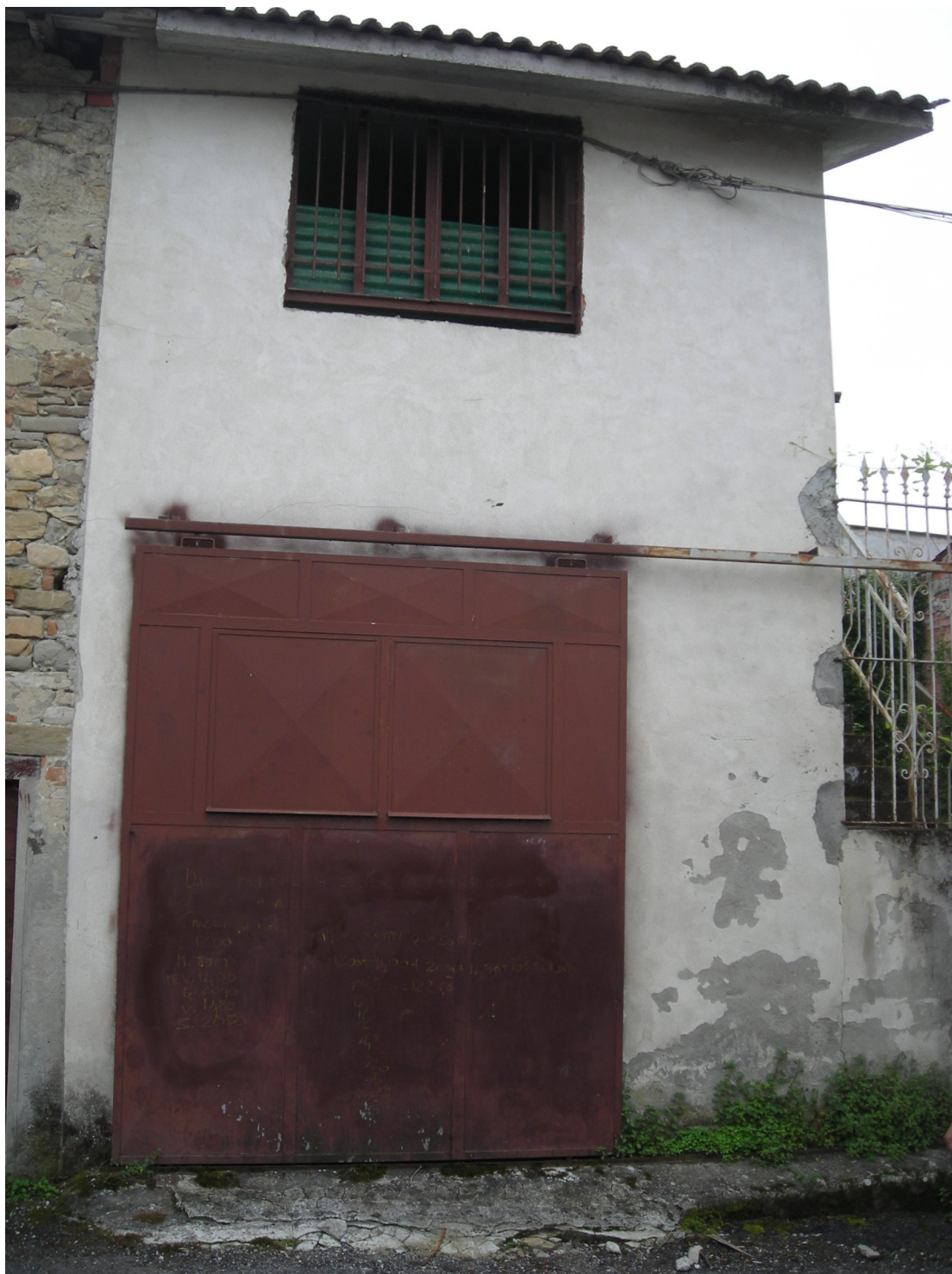
Lotto 2 Mappale 667 Box al P.T. e deposito al P1– vista da Vicolo della Corte
