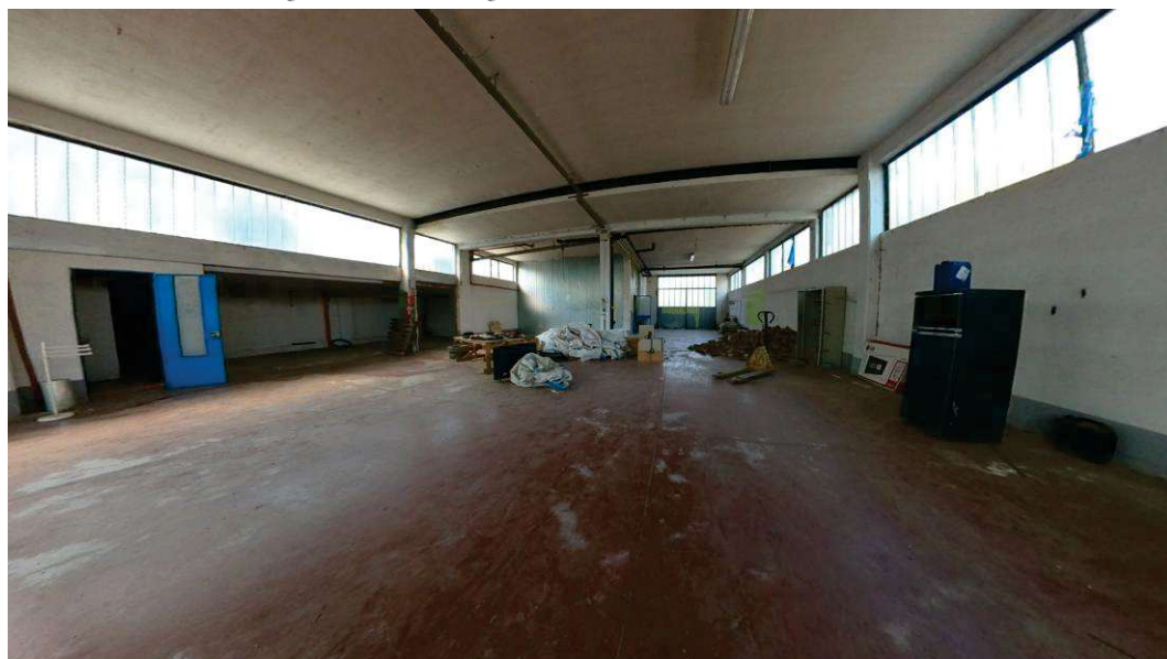
Foto 02 - Laboratorio Artigiano - Vista Interna
