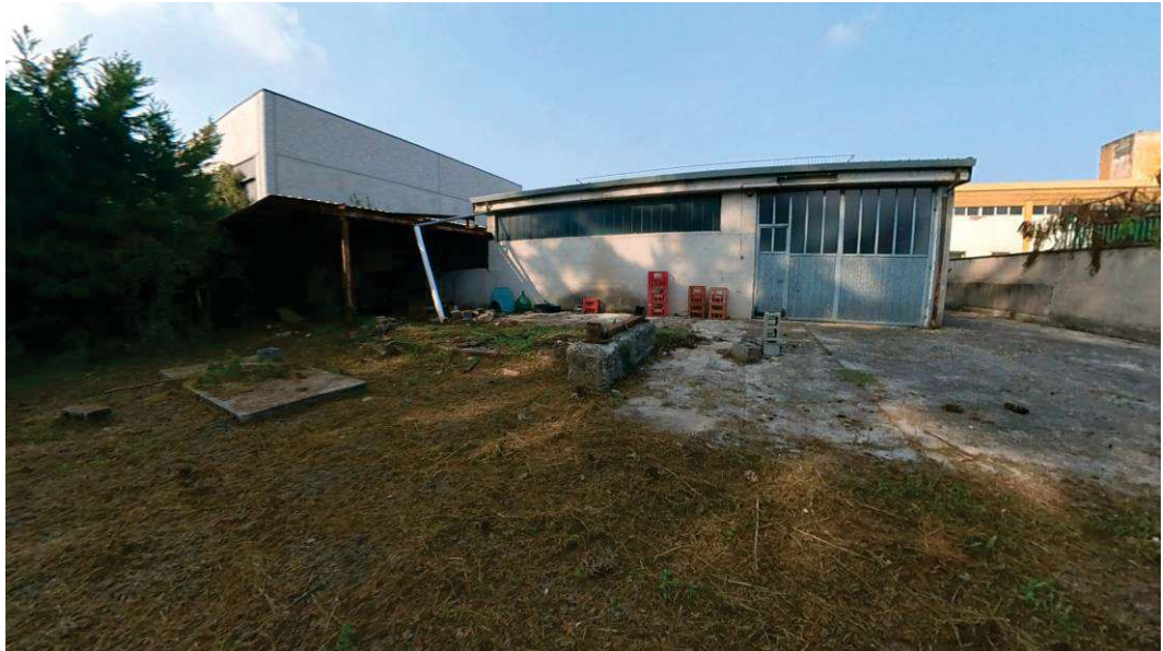
Foto 25 – Cortile Posteriore e Tettoia
