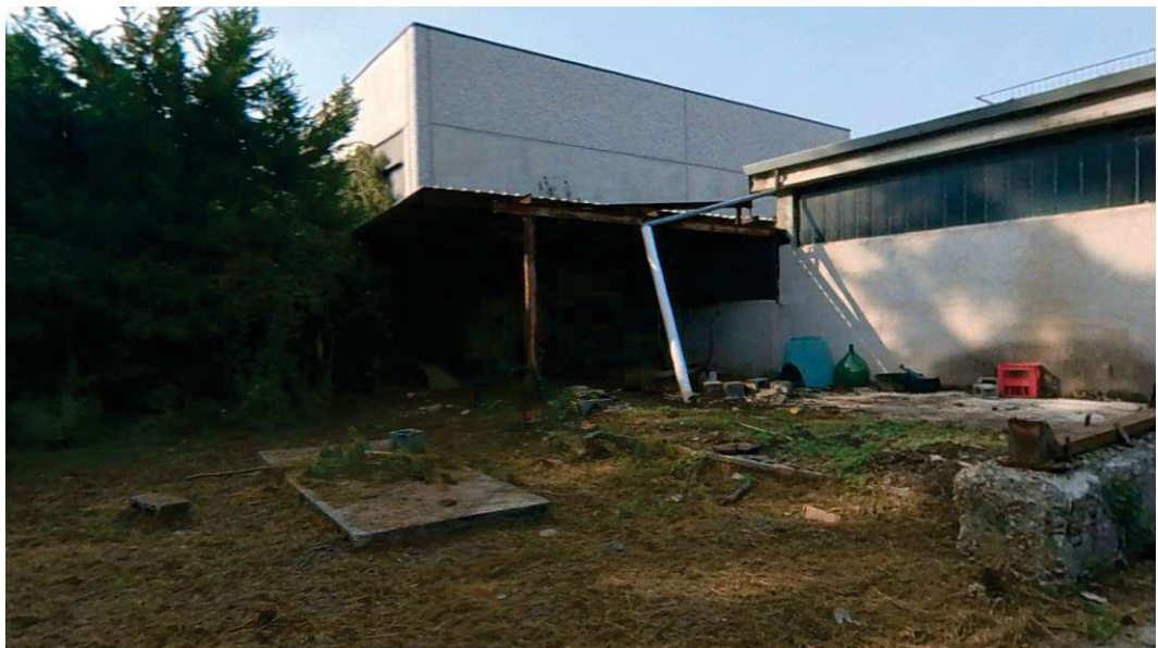
Foto 26 – Cortile Posteriore e Tettoia
