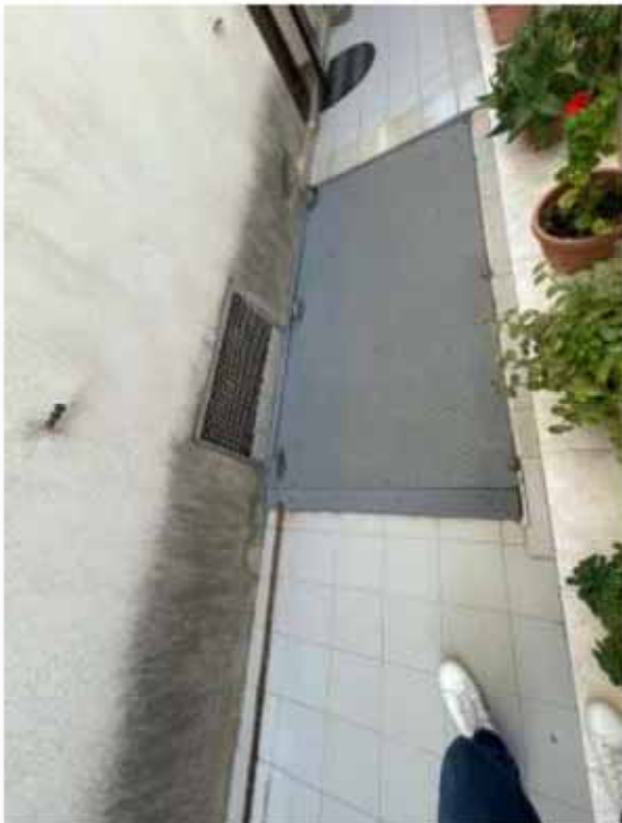
FOTO 05 - botola ingresso cantina (altra proprietà)
