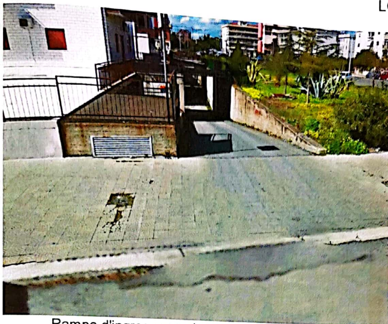
Rampa d'ingresso condominiale da Via Brennero
