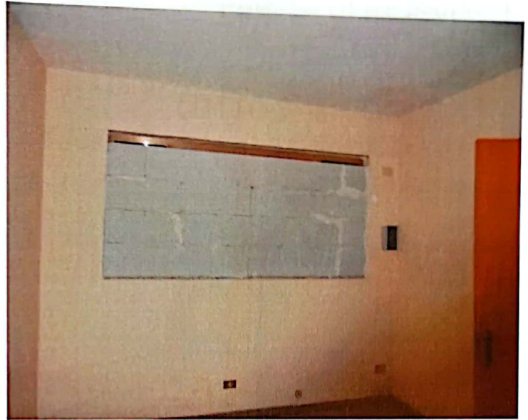
Foto n. 10: Deposito (finestra murata)
