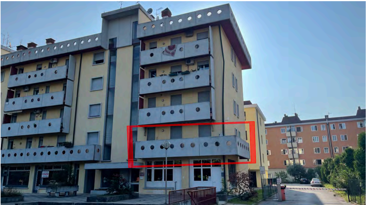
Foto A – Vista esterna
