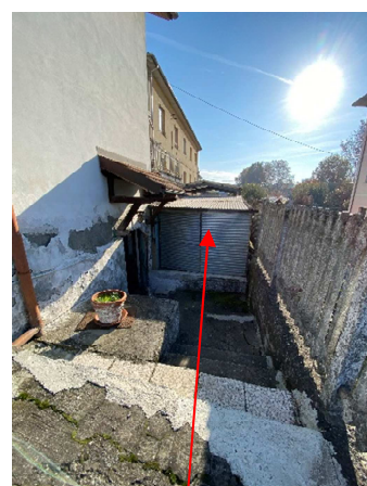
strutture realizzate con materiali eterogenei
