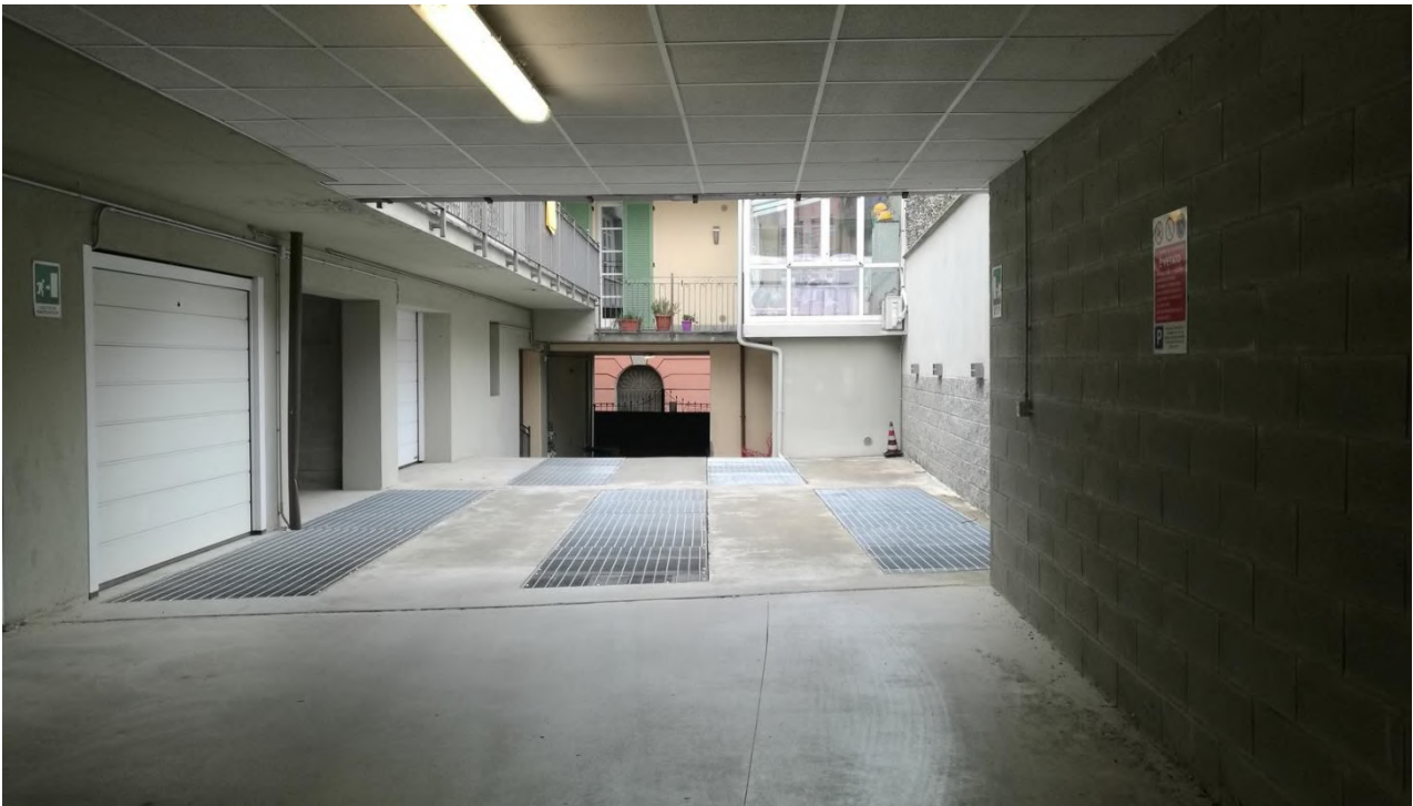
Foto 2 – Vista dell'ingresso e corridoio di manovra comune
