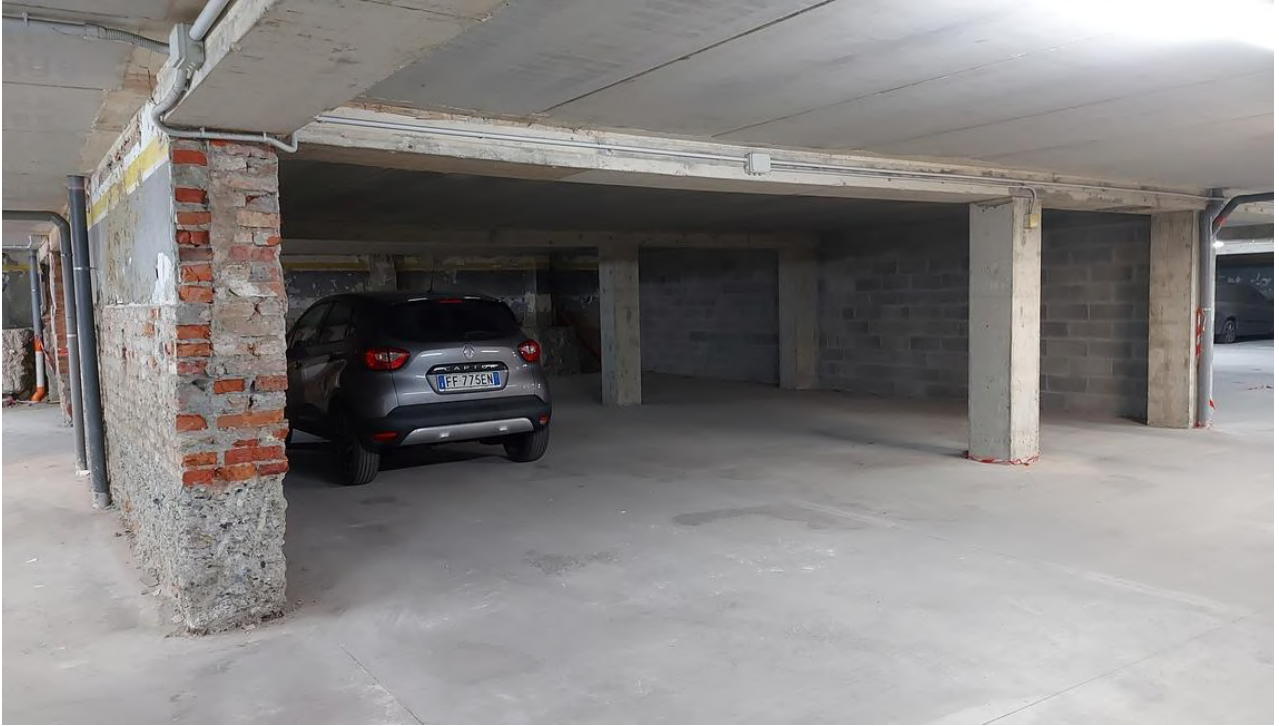
Foto 30 – Vista dal corridoio di manovra comune
