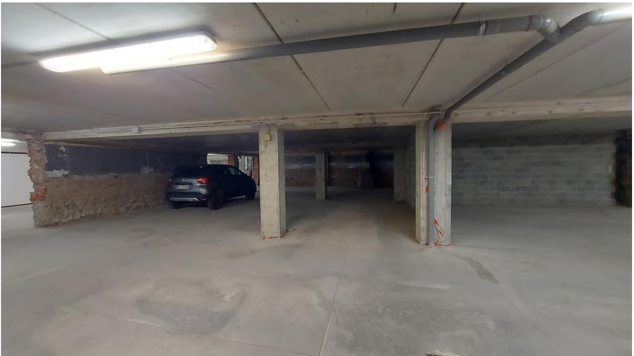
Foto 29 – Vista dal corridoio di manovra comune
