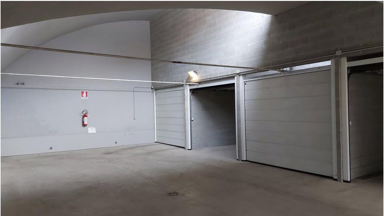
Foto 3 – Vista dal corridoio di manovra comune
