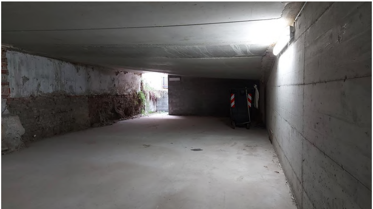
Foto 25 – Vista della zona sotto rampa
