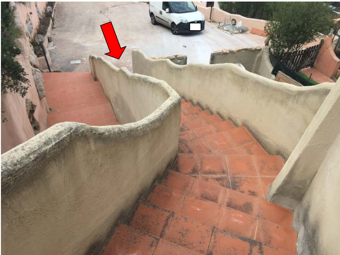
Foto n. 3 – veduta della scala di accesso all'immobile di cui trattasi
