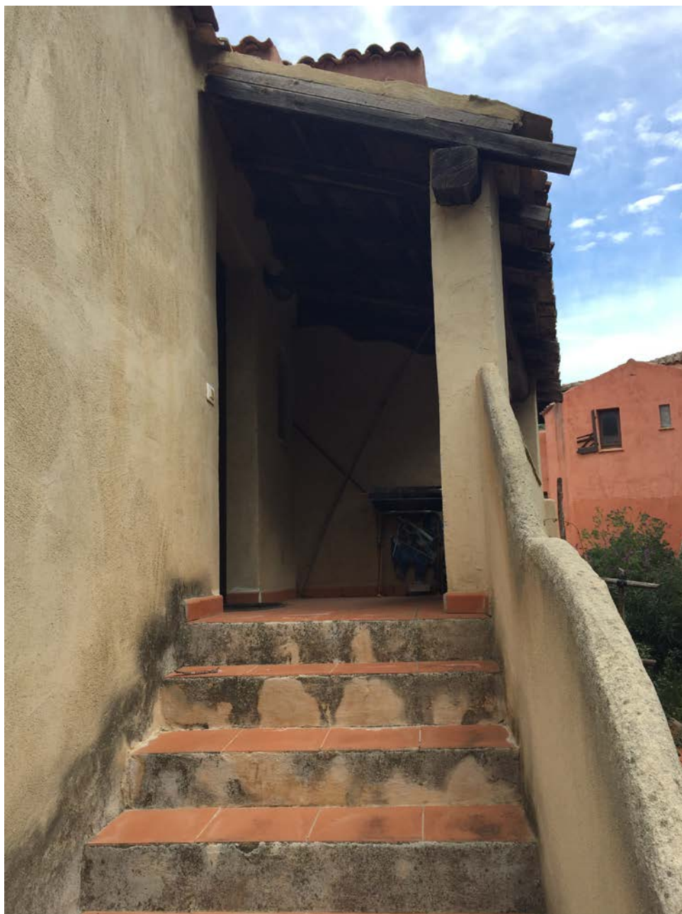
Foto n. 4 – veduta dell'ingresso dell'immobile di cui trattasi – Sub 4.
