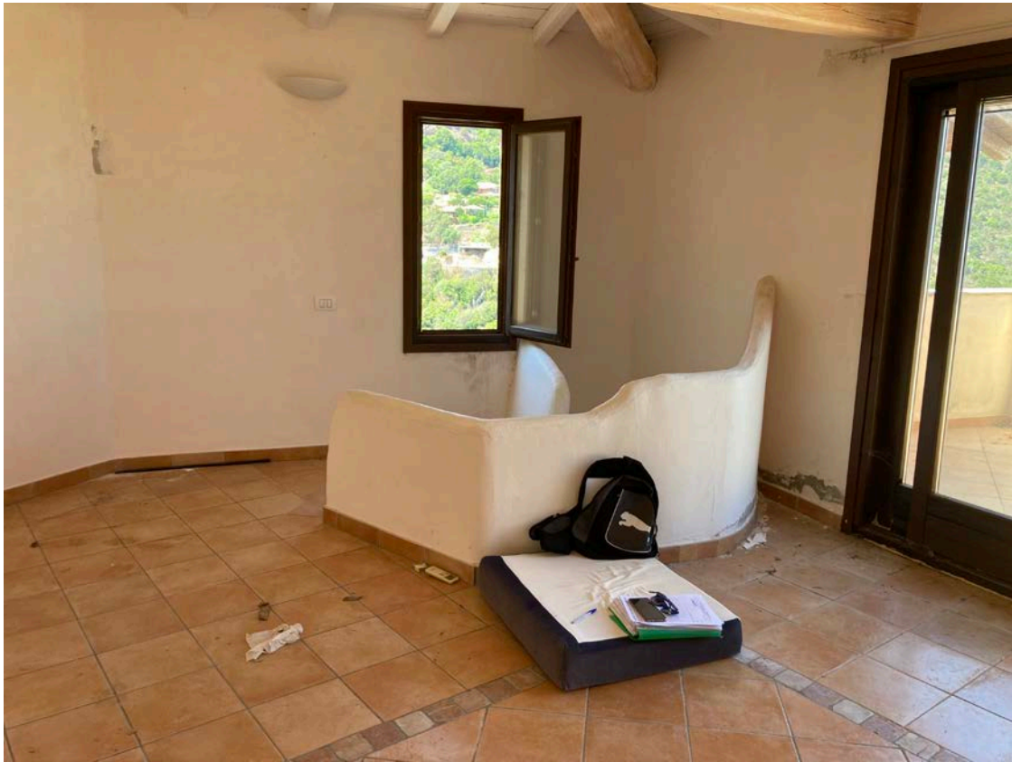
Foto n. 11 – veduta della scala interna, dell’immobile oggetto del pignoramento – Sub 4
