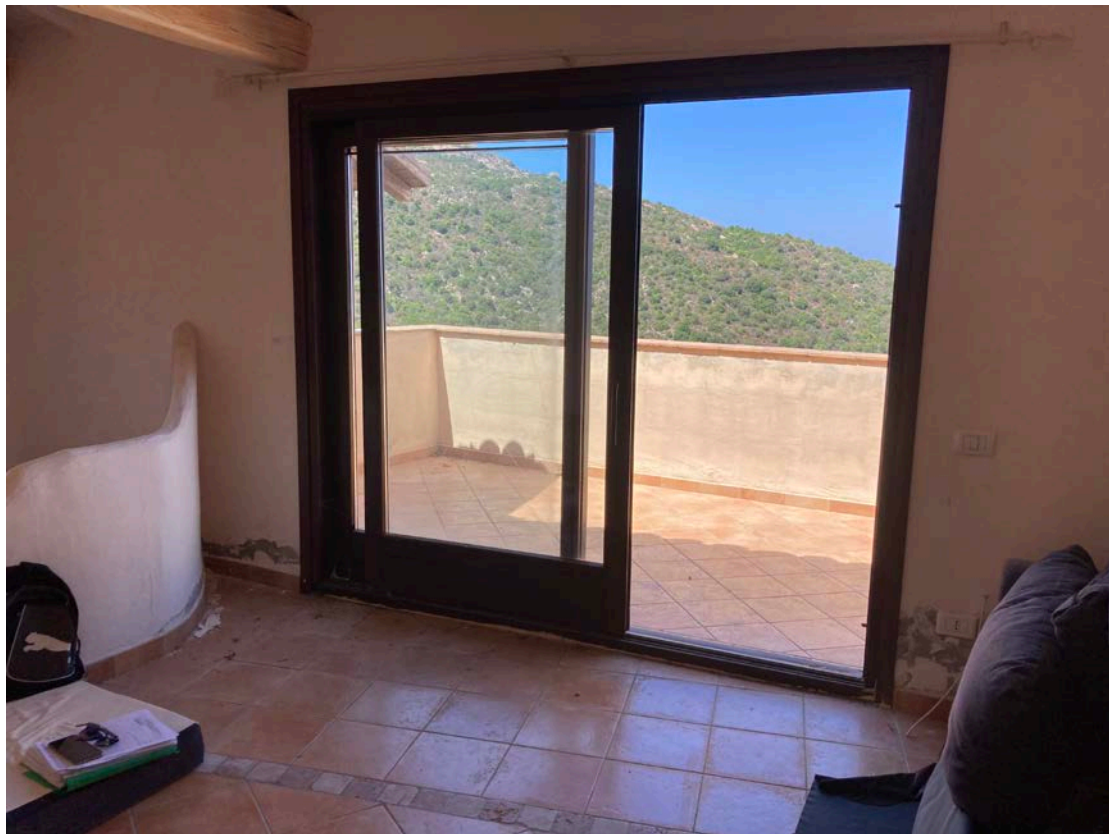
Foto n. 12 – veduta del terrazzo al piano 1°
