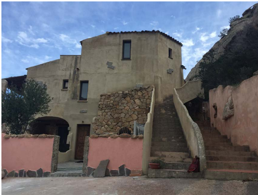
Foto n. 1 – veduta panoramica lato est, dell’edificio di cui al Mappale 1045
