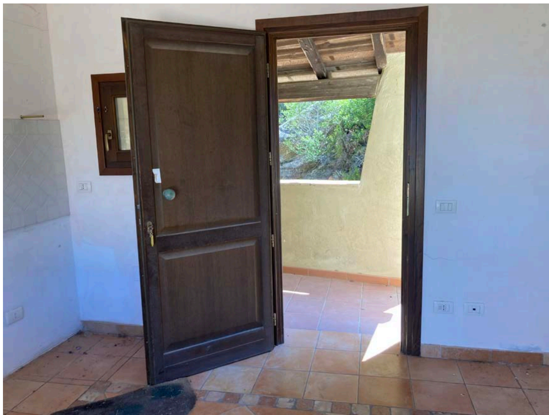
Foto n. 9 – veduta dell'ingresso al Piano 1°, dell'immobile oggetto del pignoramento – Sub 4
