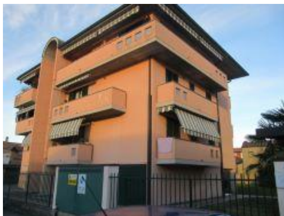
edificio fronte strada
