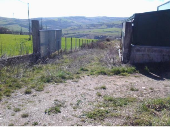
Foto cancello di ferro e recinzione terreno
