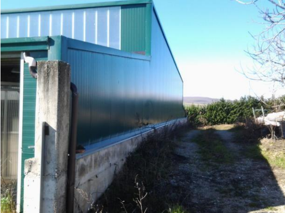
Foto prospetto lato a monte
