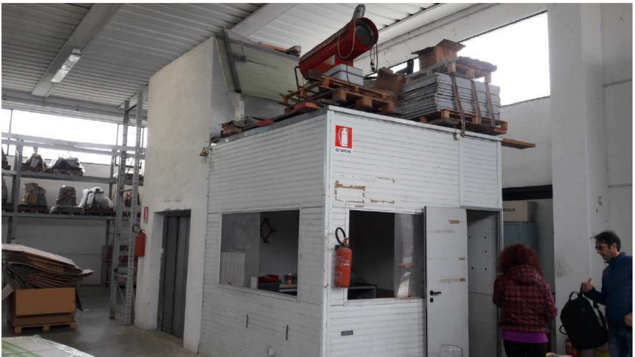
Blocco ascensore al piano primo zona opificio fuoriterra
