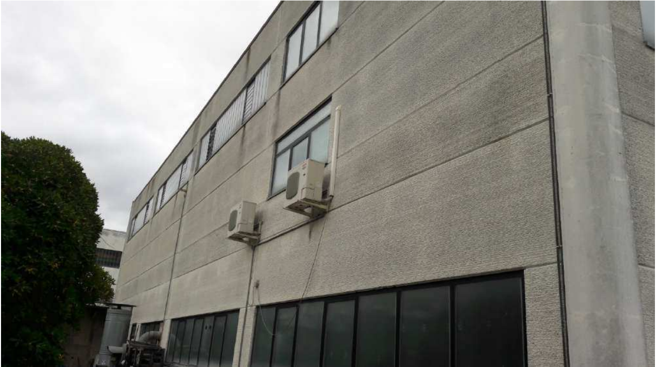
Vista esterna fianco lato sud-est
