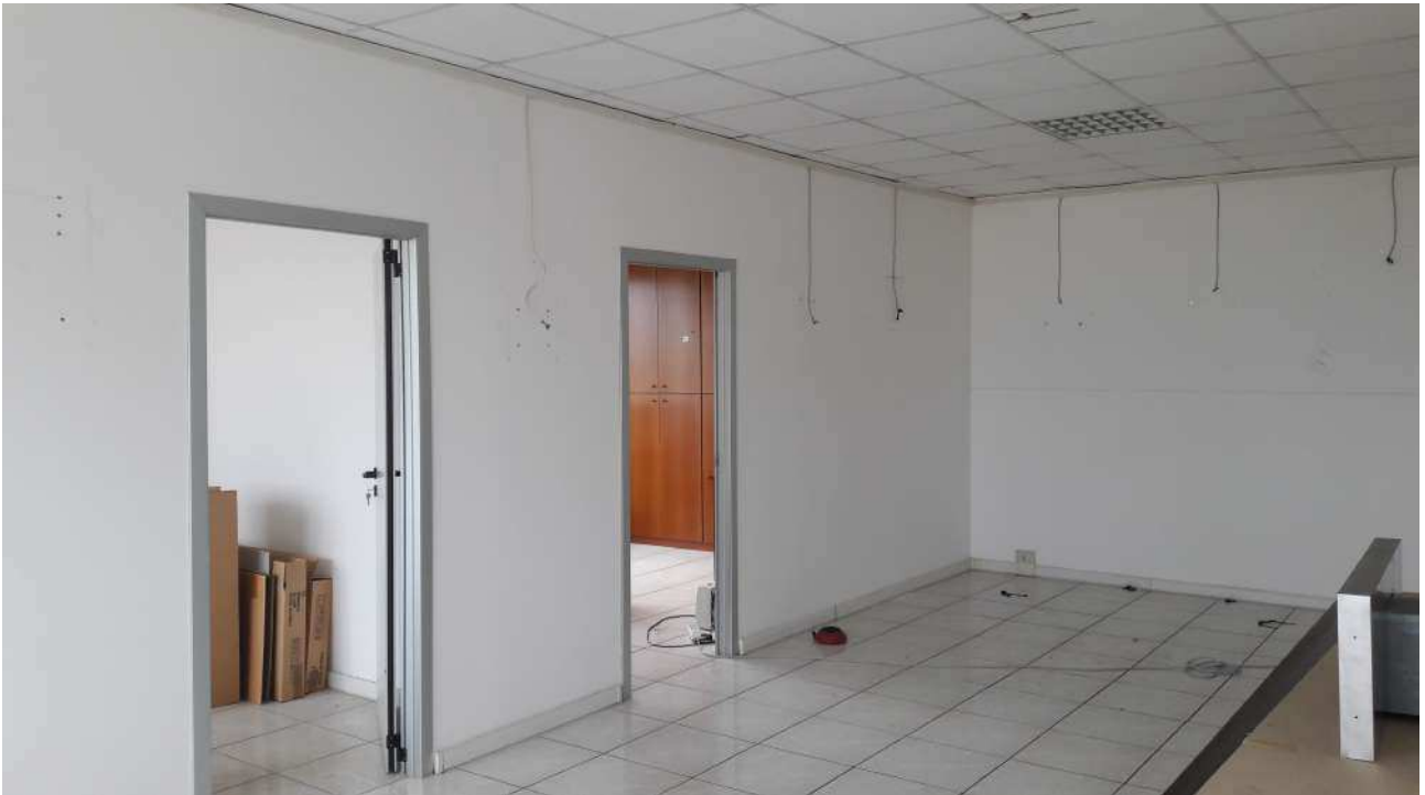
Uffici al piano secondo
