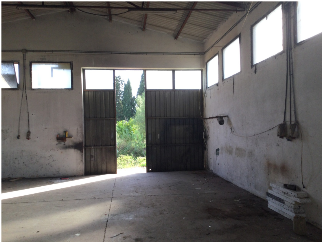
Vista dell'interno verso l'ingresso
