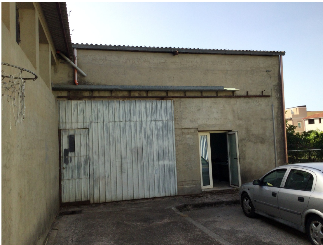
Vista del prospetto posteriore
