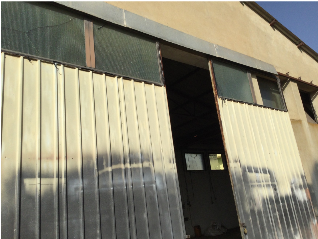
Vista dell'ingresso pedonale e carrabile
