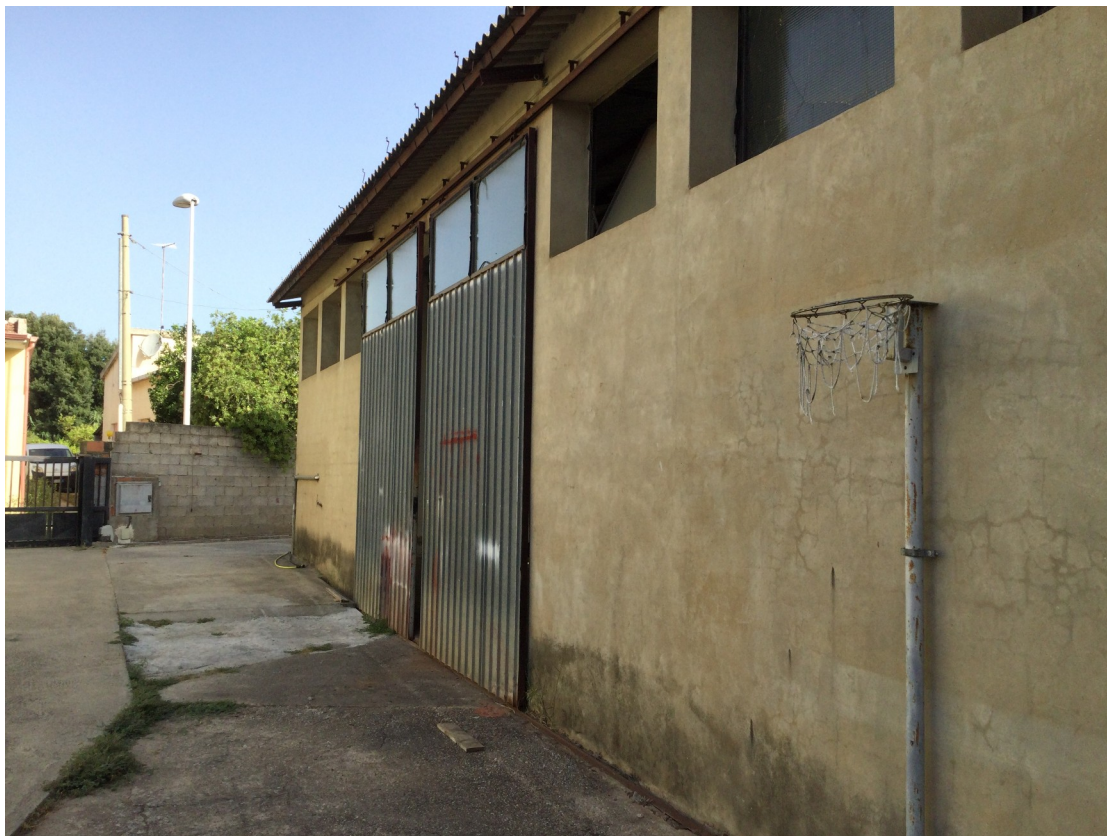
Vista del prospetto posteriore
