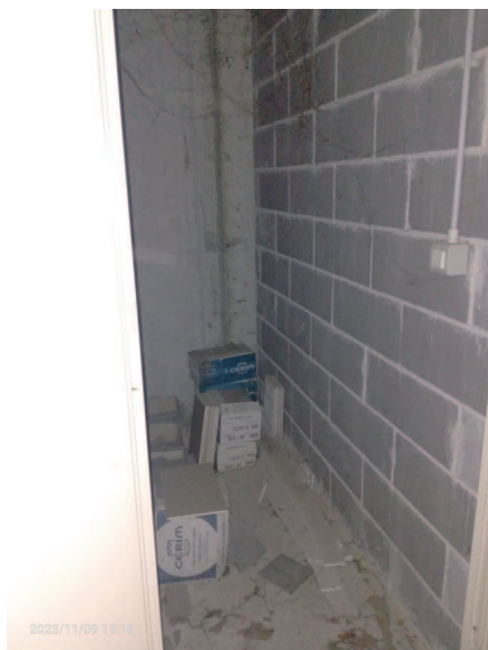
cantina sub 36 vista interno
