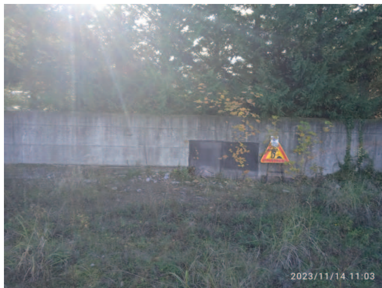
muro di cinta
