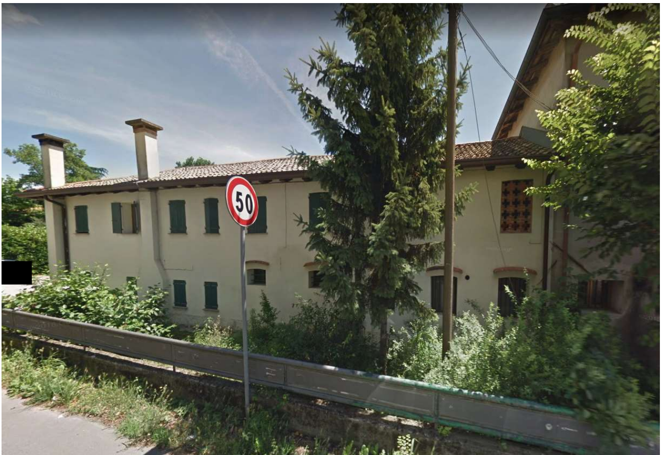
Fig. 1.13 – vista da nord dell'abitazione con deposito (sub 2-7)
